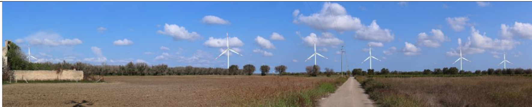
Stato Post operam dal punto di vista della "SS7 TER"
