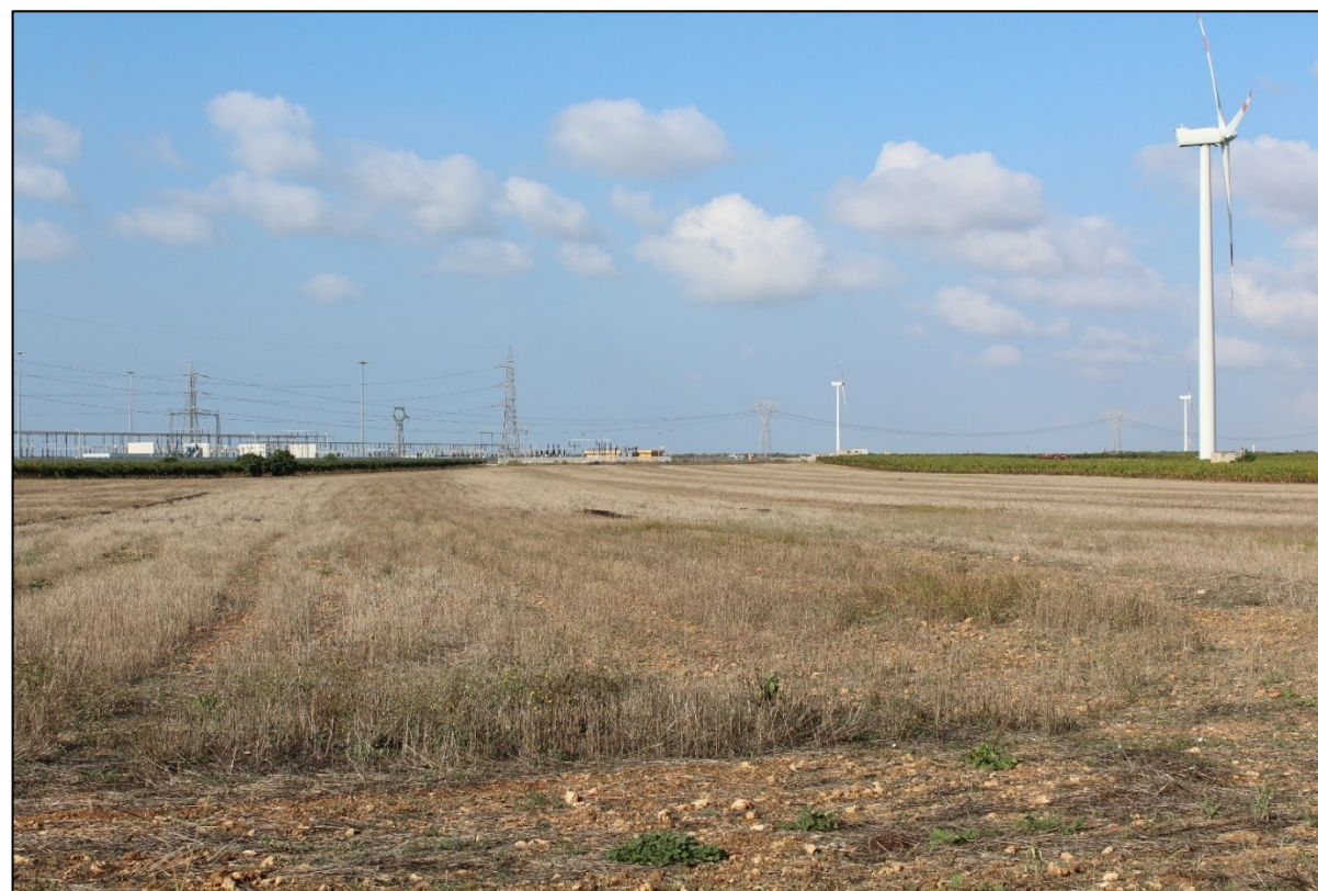
Terreni di installazione "storage", SEU ed RTN
