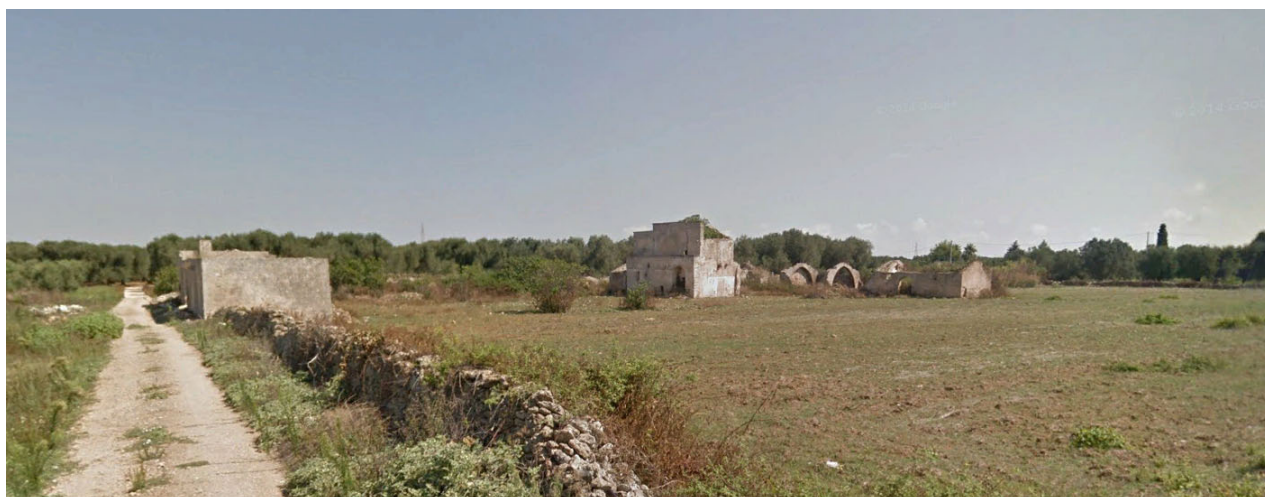
Figura 24: Masseria Capitan Pietro – UCP Segnalazione Architettonica (PPTR)
