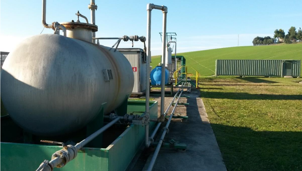
Figura 43: Serbatoio di raccolta liquidi di drenaggio con relativo bacino di contenimento e pipe way di arrivo delle acque (impianto GPI esistente analogo a quello in progetto).
