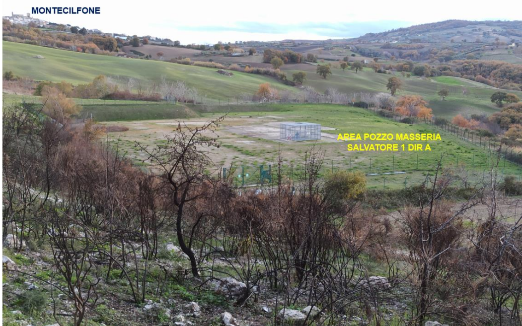
Figura 88: Foto dell'Area di Progetto scattata durante il sopralluogo del 10/12/2020 – dettaglio della postazione e delle installazioni attualmente presenti
