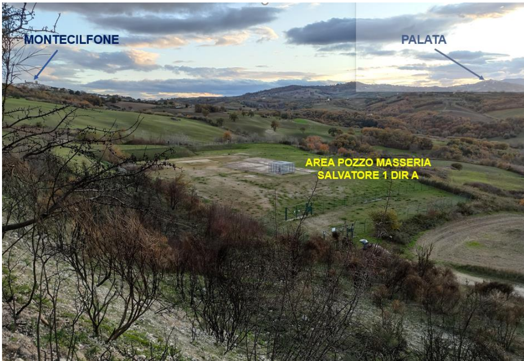
Figura 87: Foto dell'Area di Progetto scattata durante il sopralluogo del 10/12/2020
