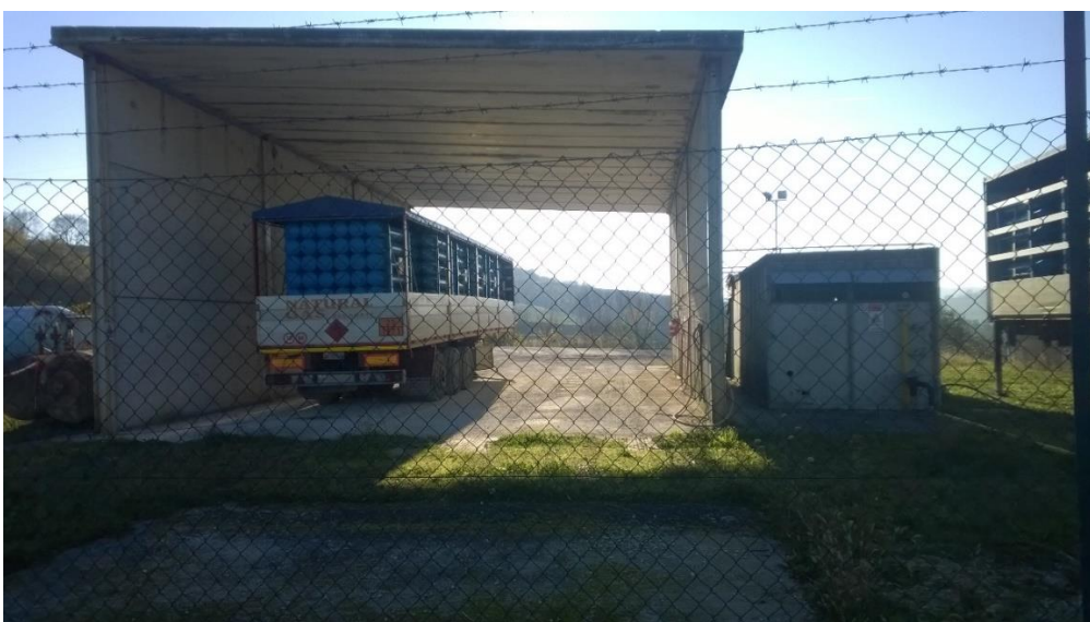
Figura 12: Esempio di configurazione in Area Utilizzatore, si noti il locale compressore sulla destra dell'immagine.
