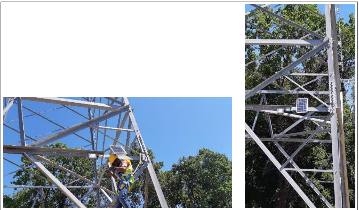
Fig. 7 - Esempio di installazione di una postazione di monitoraggio su sostegno
