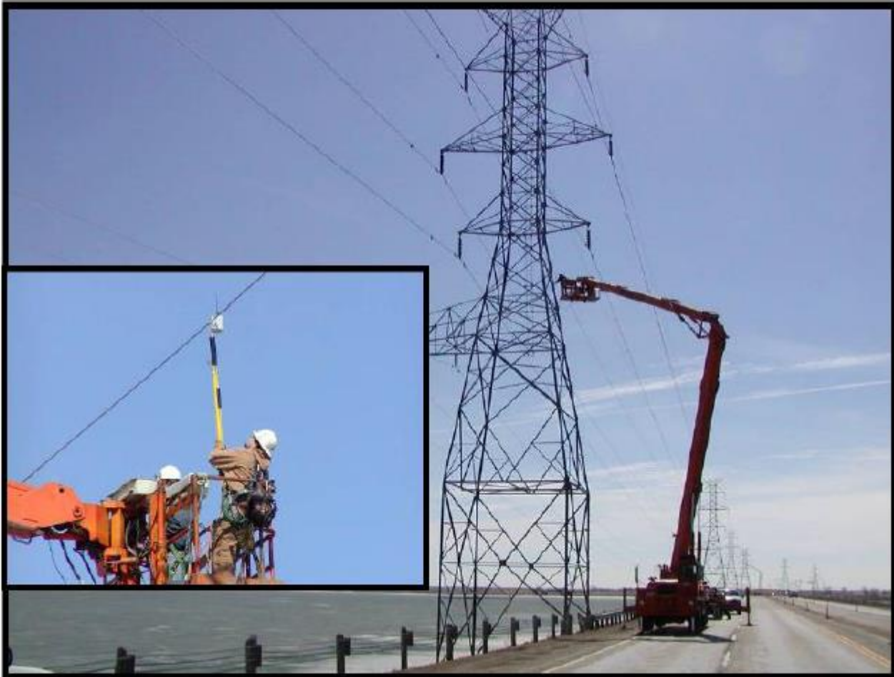
Fig. 2 – Installazione con mezzo mobile munito di cestello e operatore con hot stick (Arun et al., 2008)
