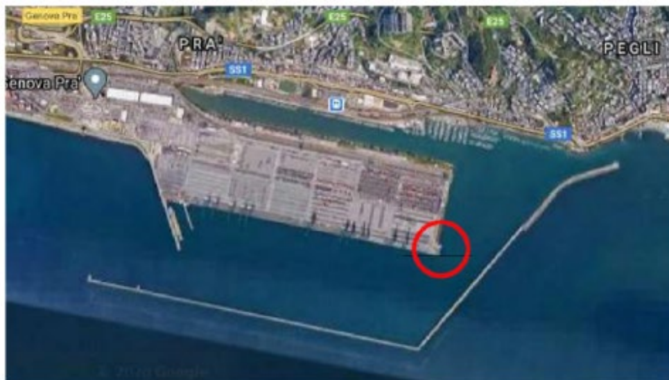
Area di cantiere A (Prà – Voltri)
