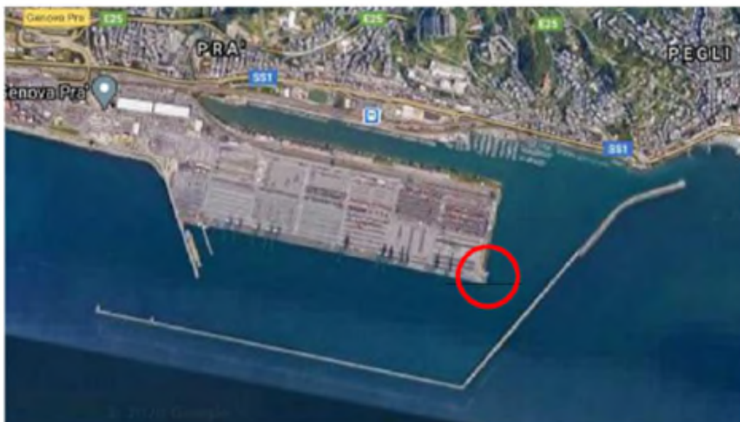
Area di cantiere A (Prà – Voltri)
