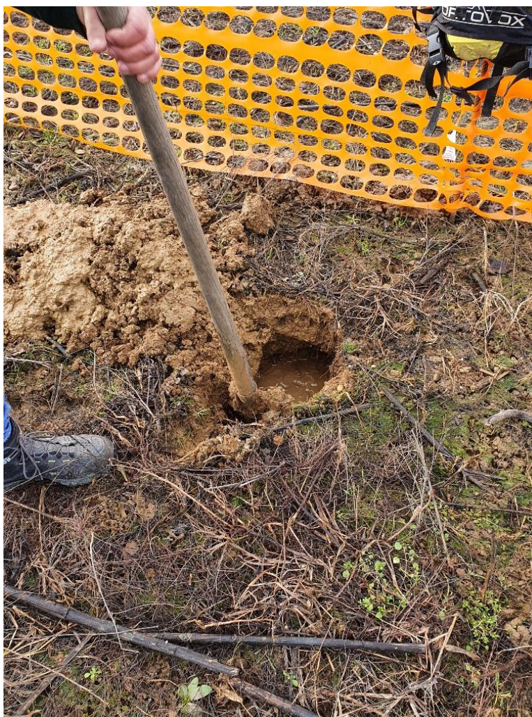
Figura 12 - Scavo manuale nel sito SUO-NL-003
