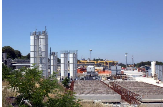
Cantiere operativo Cop7
