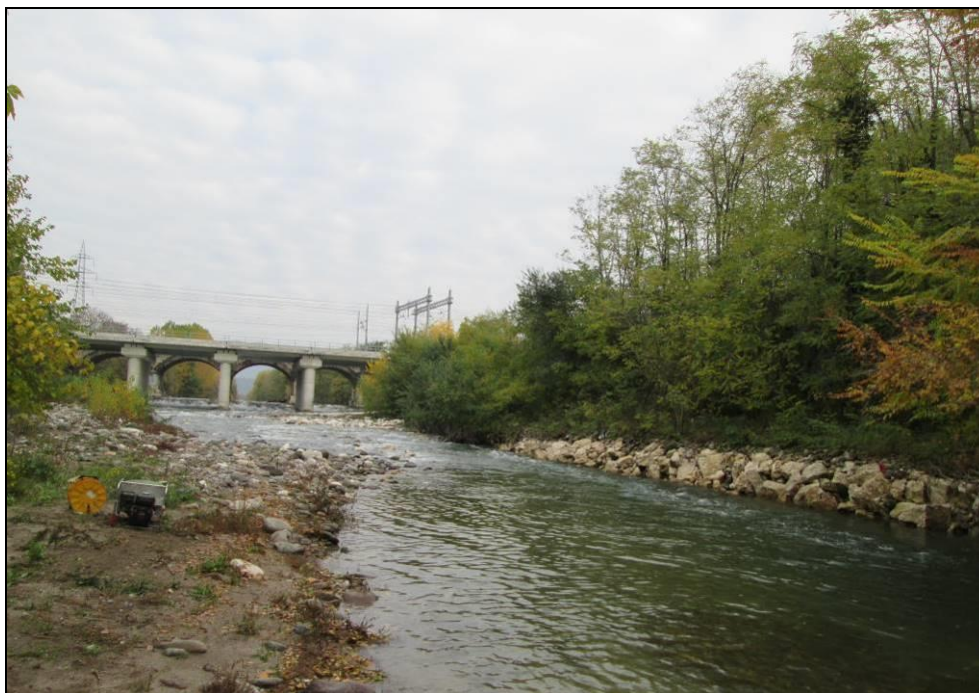
Foto 1.1 – Fiume Mella a valle del nuovo ponte della LINEA AV/AC, novembre 2021
