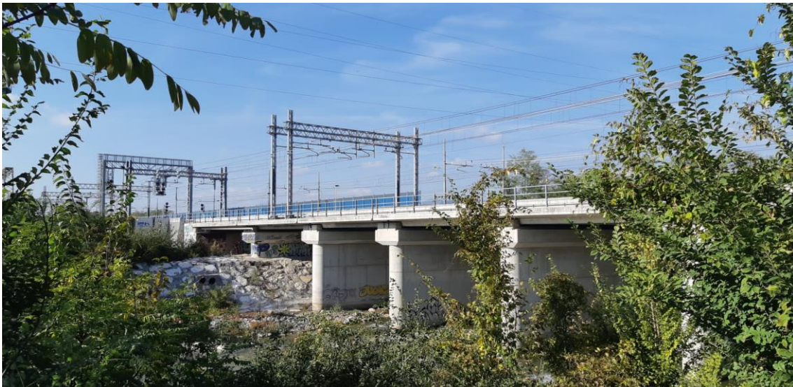
Panoramica del nuovo ponte di attraversamento del fiume Mella
