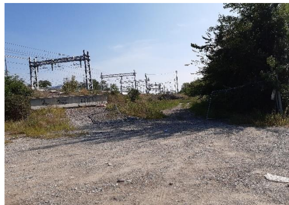
Veduta area cantiere
