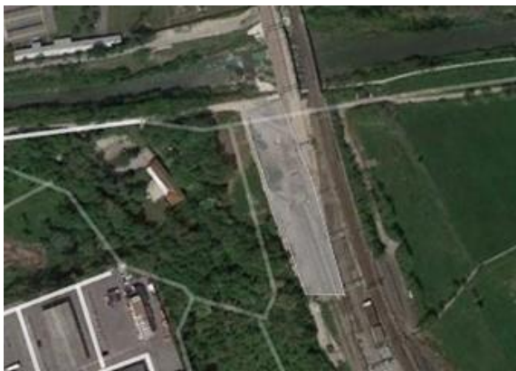
Localizzazione dell'area di cantiere posta a monte della linea ferroviaria
