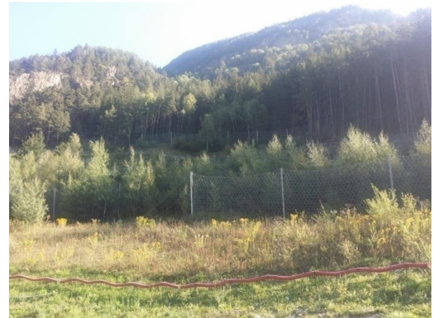
Steinschlagnetze auf dem Hang oberhalb der Baustelle
