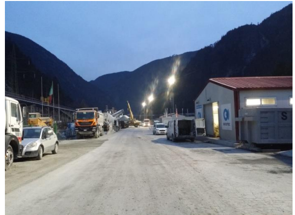
Baustelle Mauls 3 - Cantiere Mules 3
