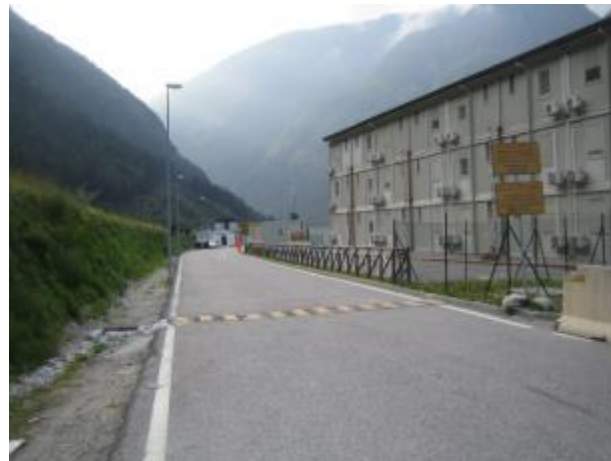
Ansicht der Baustelle Muls 3 Vista cantiere Muls 3
