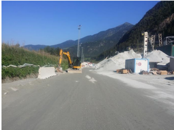
Baustelle Mauls 1 - cantiere Mules 1
