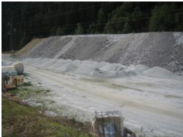
Ausbruchmaterial Materiale di scavo
