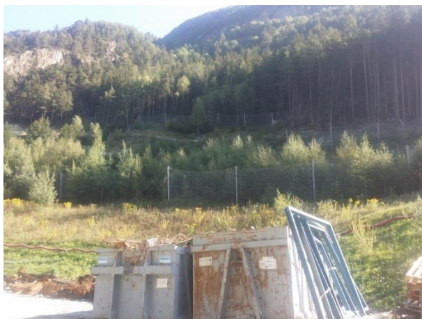
Baustelle Muls1 -Cantiere di Muls1
