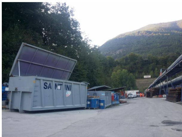
Baustelle Unterplattner / Cantiere di Unterplattner
