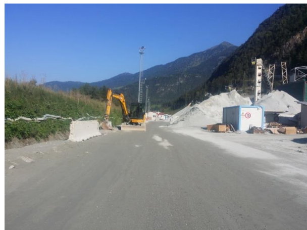
Baustelle Muls 1 - Cantiere Muls 1 Sichtschutzdamm - Argine coprivista
