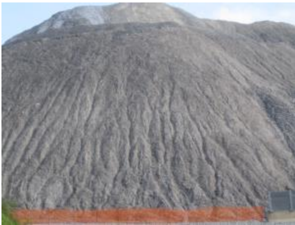
Erosionen an den südlichen Böschungen Processi erosivi sulle scarpate meridionali
