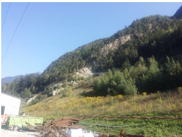
Baustelle Muls 1 - Cantiere Muls 1 Base del versante
