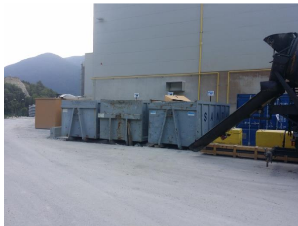
Baustelle Hinterrigger / Cantiere di Hinterrigger
