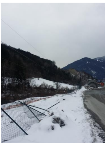
Schäden am Begrenzungsnetz / Danni alla rete di confine
