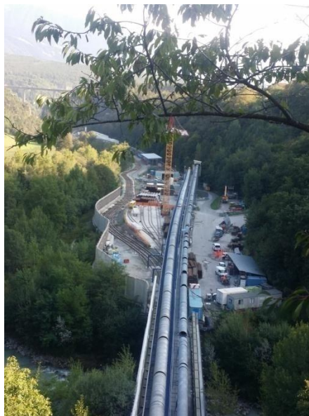
Ansicht der Baustelle / Vista area di cantiere
