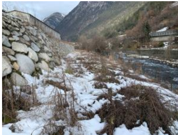
Uferzone Fascia ripariale
