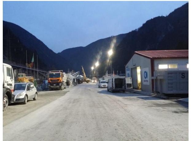
Ansicht der Baustelle Muls 1 Vista cantiere Muls 1
