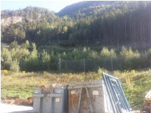
Steinschlagnetze auf dem Hang oberhalb der Baustelle
