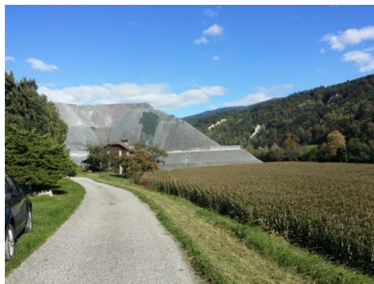
Ansicht der Baustelle / Vista del cantiere
