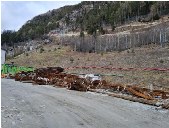
Steinschlagnetze auf dem Hang oberhalb der Baustelle / Reti paramassi sul versante che sovrasta il cantiere
