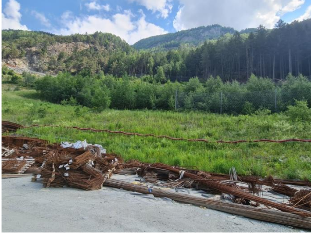
Baustelle Muls 1 - Cantiere Muls 1 Base del versante
