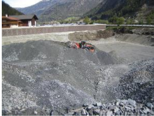
Sektor Nord der Baustelle Settore nord del cantiere
