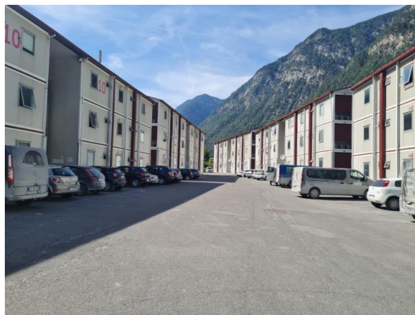
Ansicht der Baustelle Vista area di cantiere
