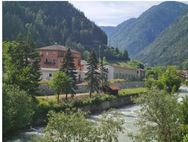
Vista del cantiere dalla strada statale
