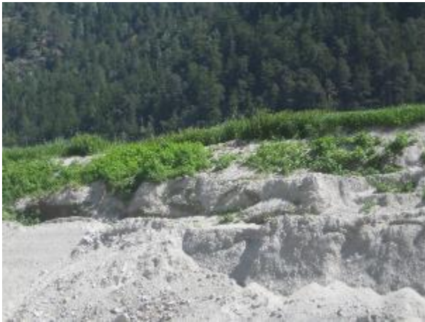
Böschung zur Baustelle ,Seite Bahn Scarpata rivolta verso il cantiere, lato ferrovia
