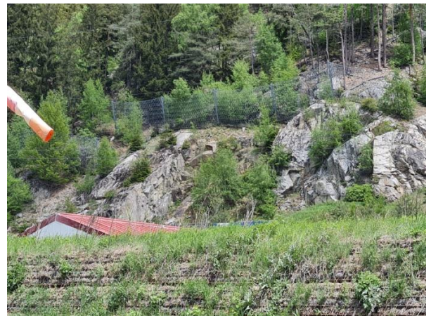
Steinschlagnetze auf dem Hang oberhalb der Baustelle / Reti paramassi sul versante che sovrasta il cantiere
