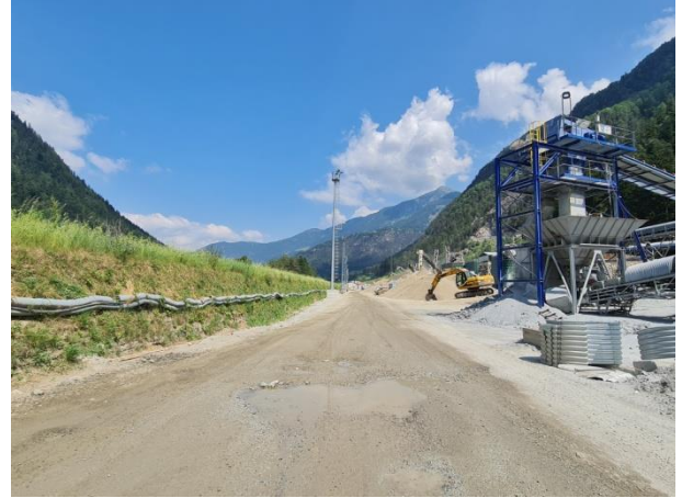
Baustelle Muls 1 - Cantiere Muls 1 Sichtschutzdamm - Argine coprivista
