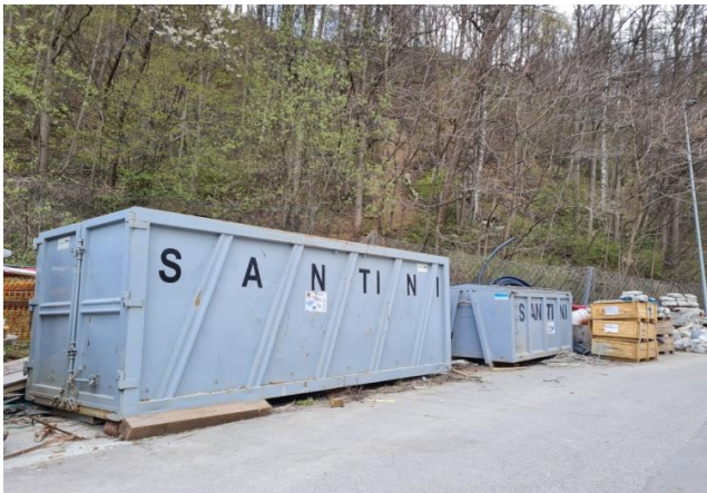
Baustelle Unterplattner Cantiere di Unterplattner
