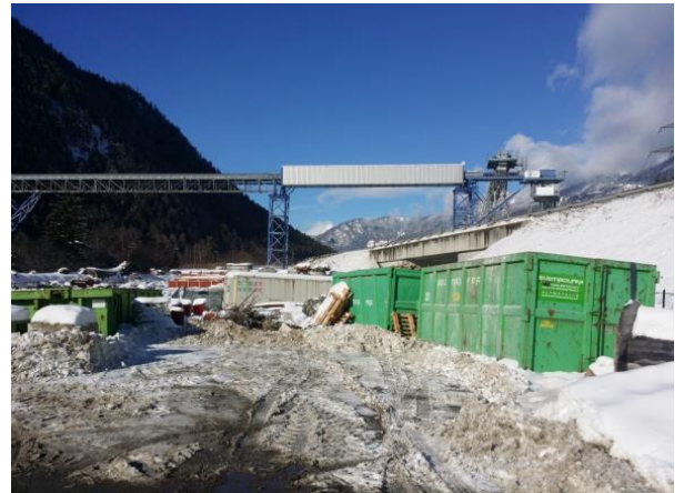
Baustelle Mauls 2 Cantiere di Mules 2
