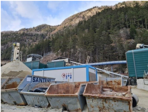
Baustelle Mauls 1 Cantiere di Mules 1
