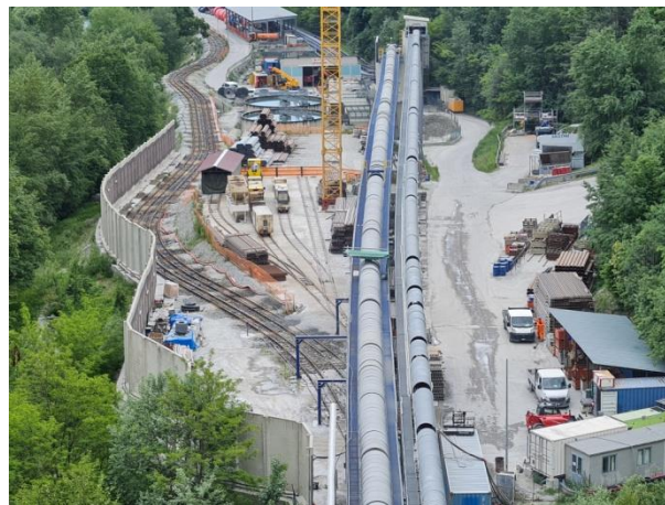
Ansicht der Baustelle
