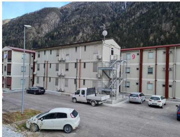
Ansicht der Baustelle Vista area di cantiere
