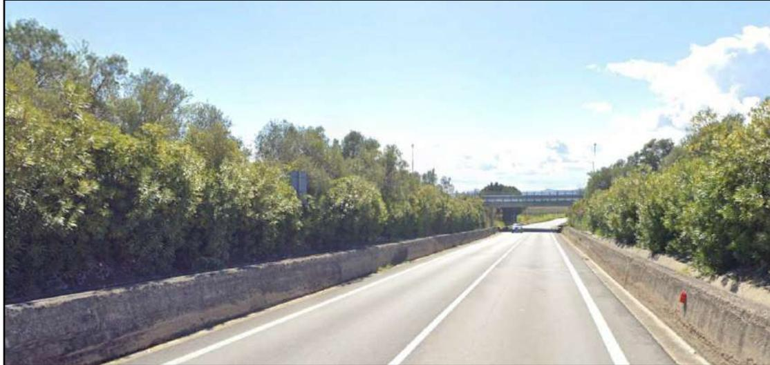
Si consideri infine che l'infrastruttura A14 Bologna-Bari, appartenente alla rete viaria principale, presenta ciascuna una capacità veicolare teorica di circa 1.700 veicoli equivalenti/h per senso di marcia (rif Highway Capacity Manual- Transportation Board, manuale teorico statunitense)
