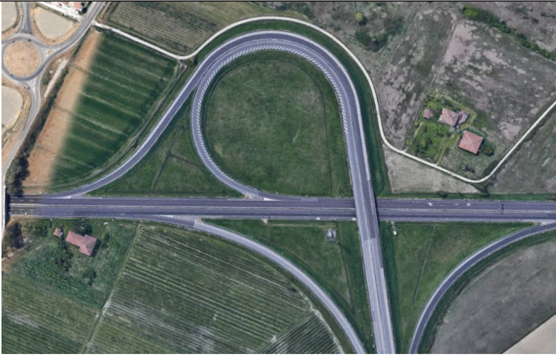
Figura 2 – Svincolo di Ferrara Sud
