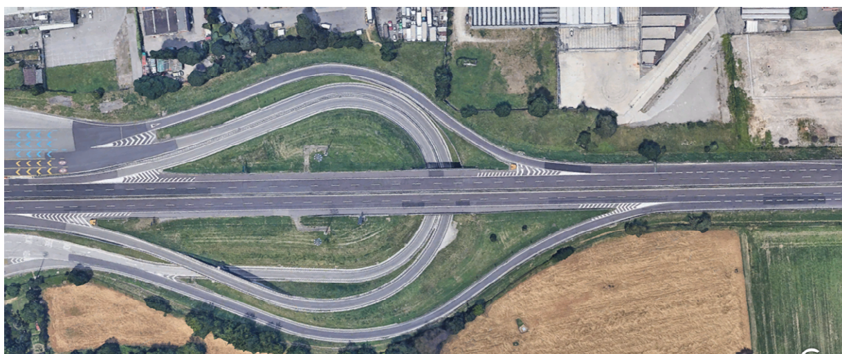
Figura 1 – Svincolo di Bologna Arcoveggio
