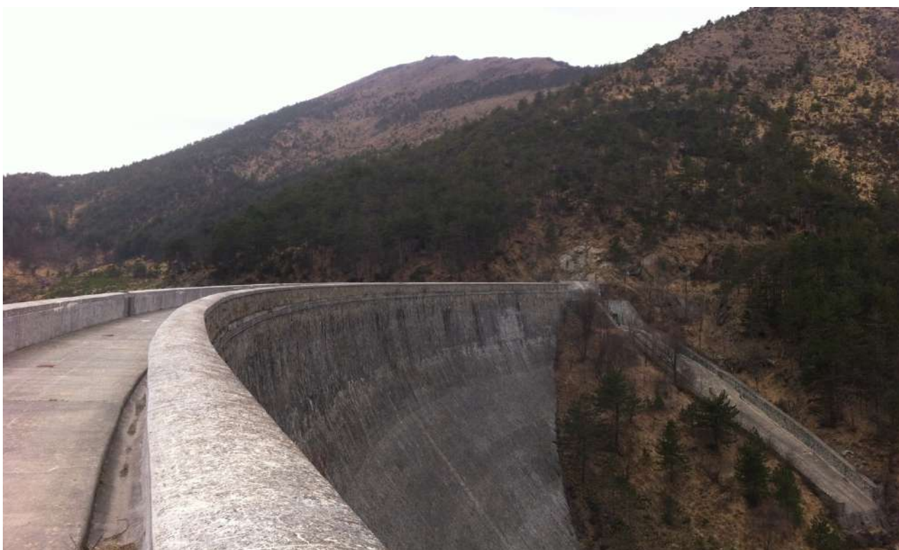
A2. 02/03/2017 – Paramento di valle e scarico di superficie.
