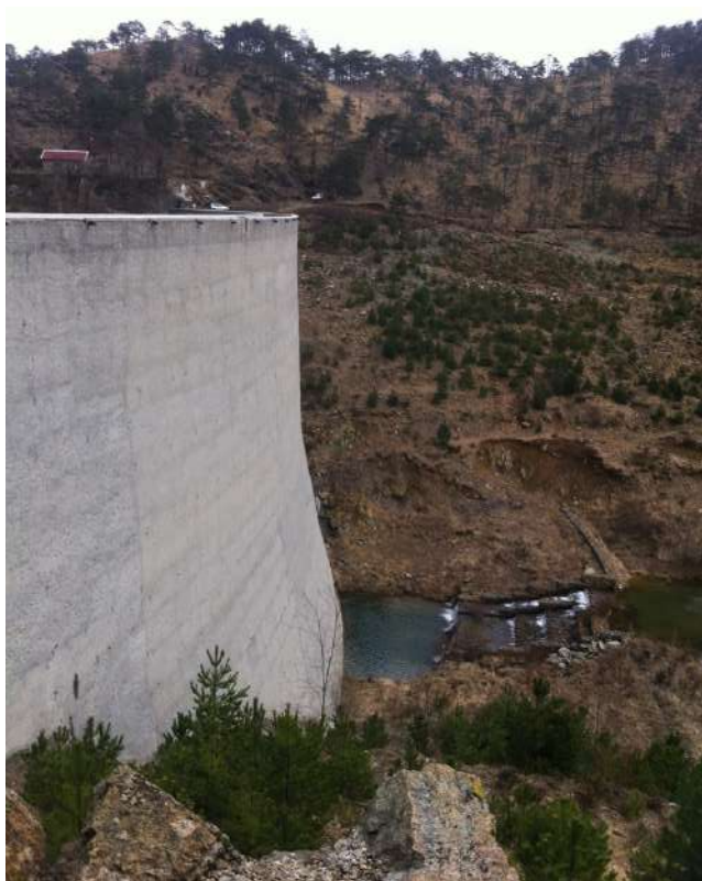
A3. 02/03/2017 – Paramento di monte.
