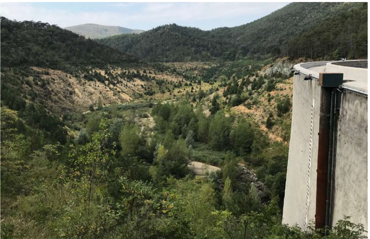
A6. 09/09/2021 – Invaso e paramento di monte.
