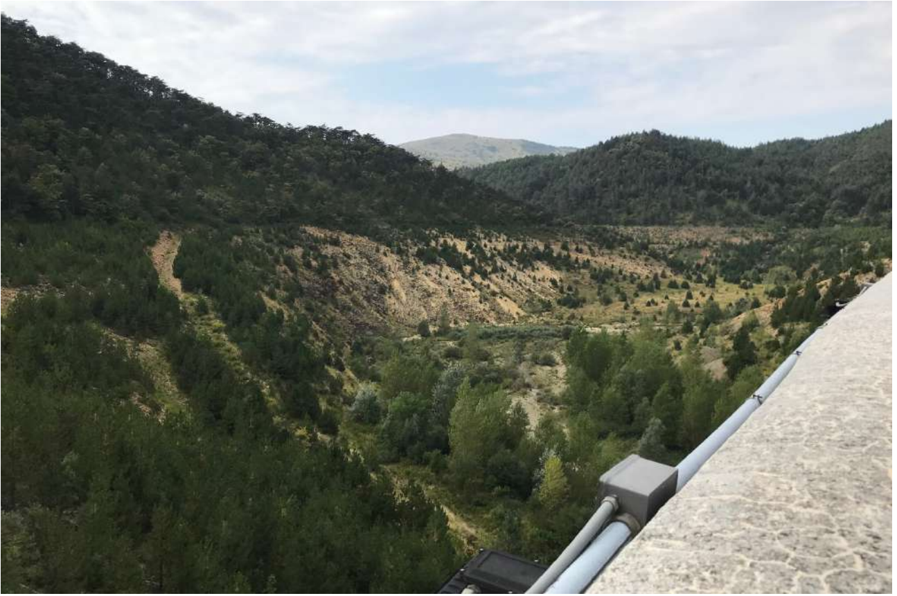
A7. 09/09/2021 – Sponda destra invaso.
