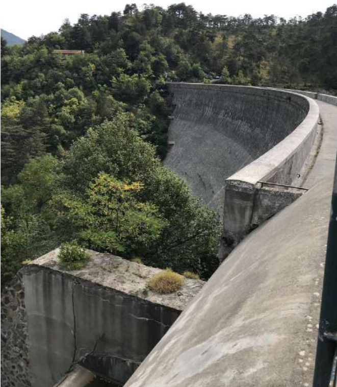
A12. 09/09/2021 – Coronamento e zona dello scarico di superficie.
