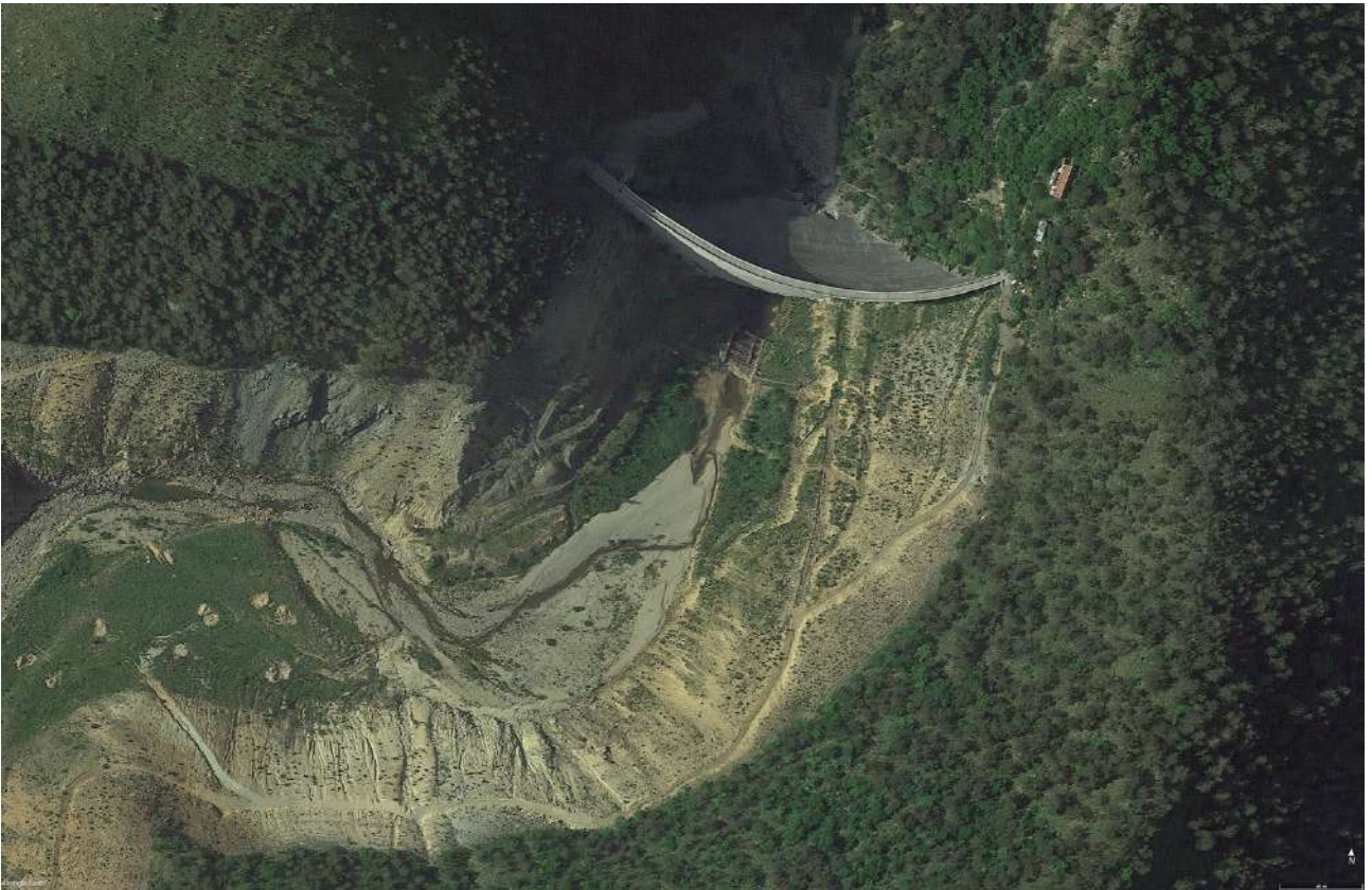
B9. Giugno 2014 – dettaglio diga e invaso di Badana.
