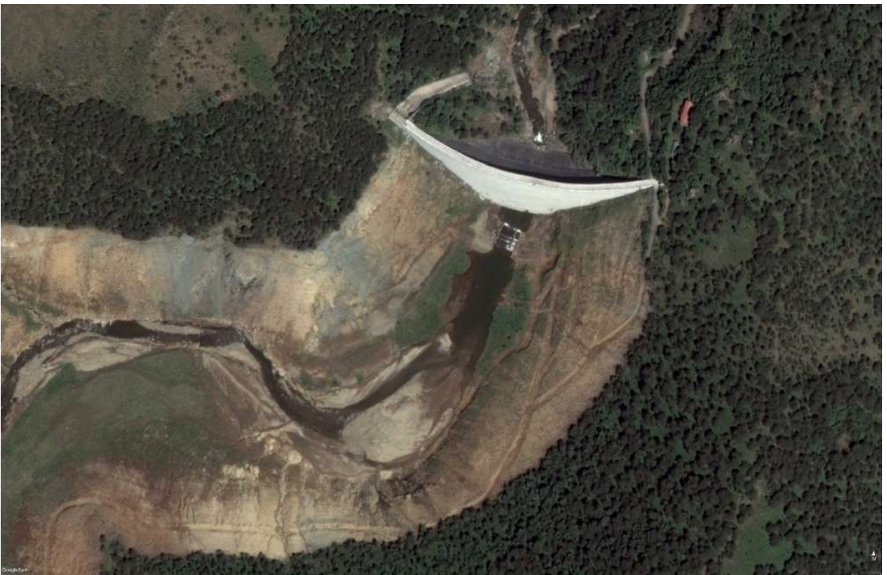
B8. Luglio 2011 – dettaglio diga e invaso di Badana.
