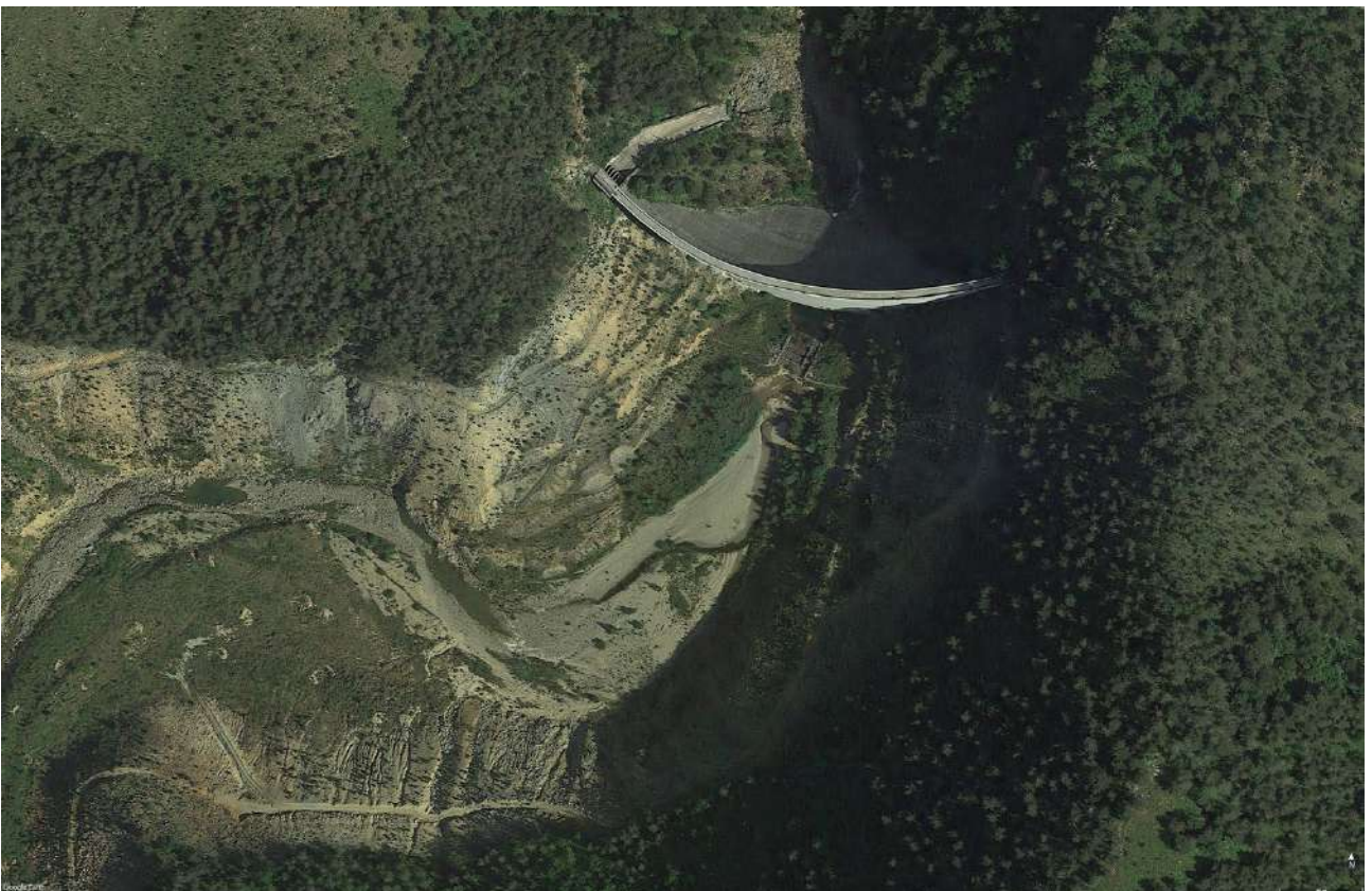
B10. Agosto 2015 – dettaglio diga e invaso di Badana.
