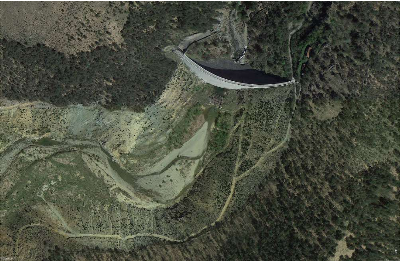
B11. Aprile 2016 – dettaglio diga e invaso di Badana.
