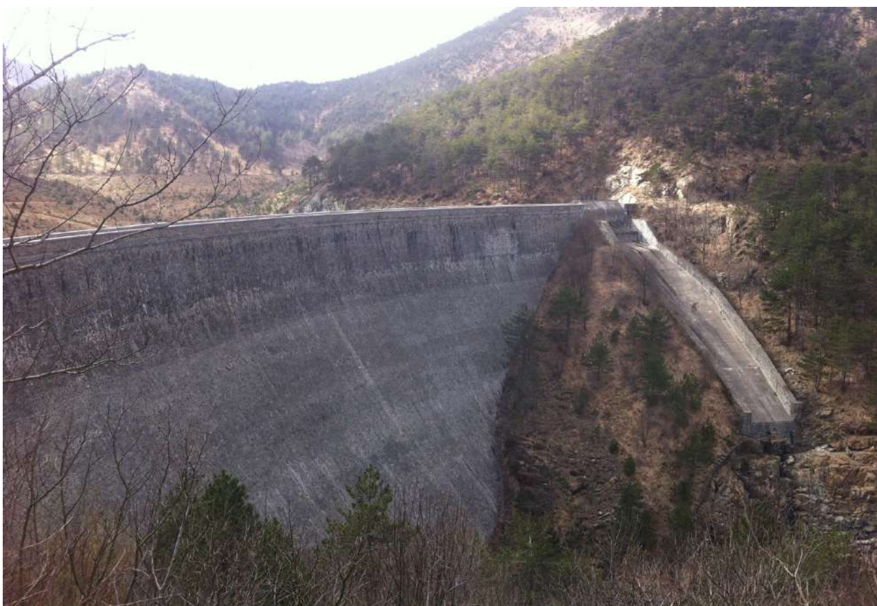
A4. 02/03/2017 – Paramento di valle e scarico di superficie.
