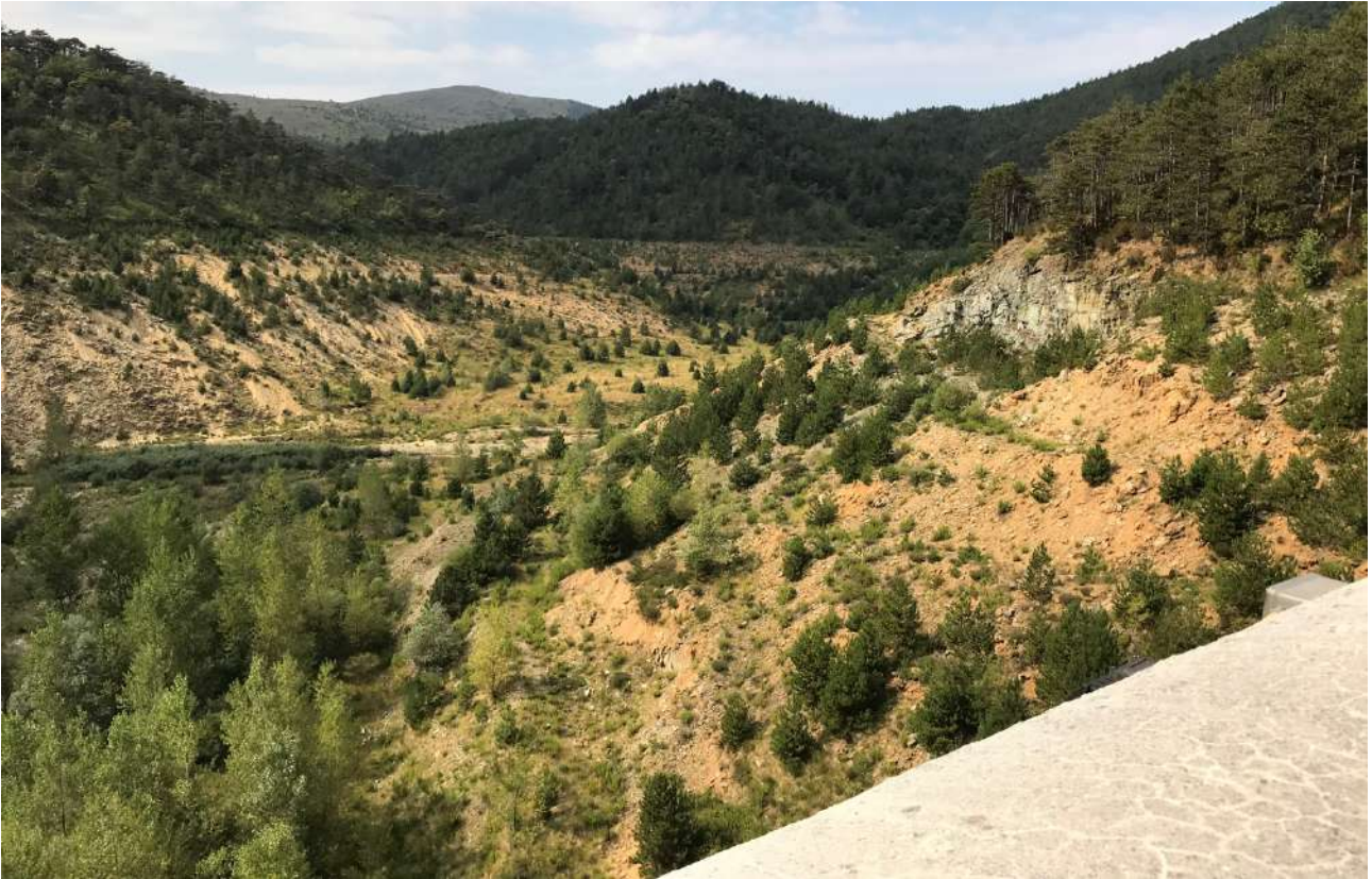
A11. 09/09/2021 – Sponda sinistra invaso.
