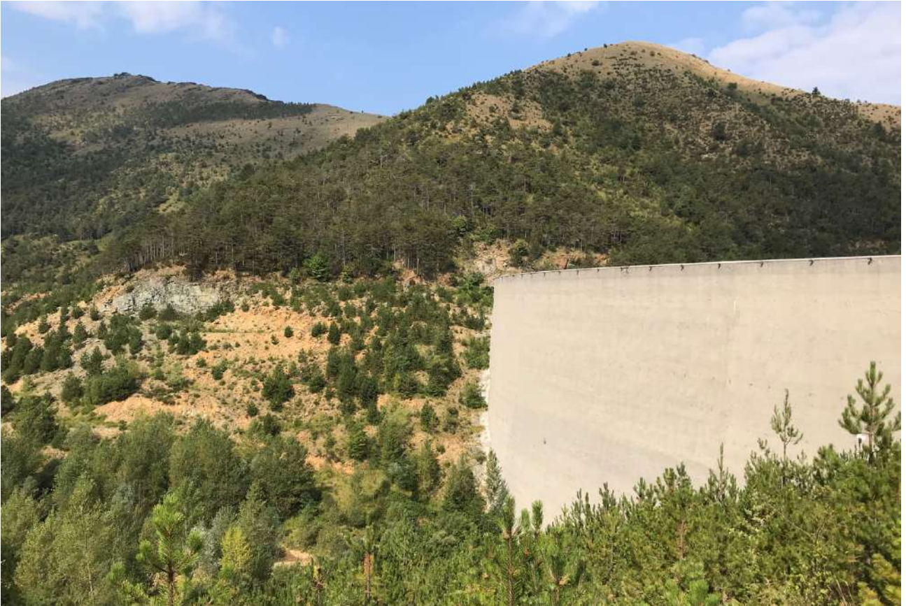
A13. 09/09/2021 – Invaso e paramento di monte.
