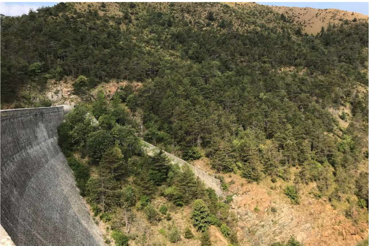
A8. 09/09/2021 – Paramento di valle e scarico di superficie.
