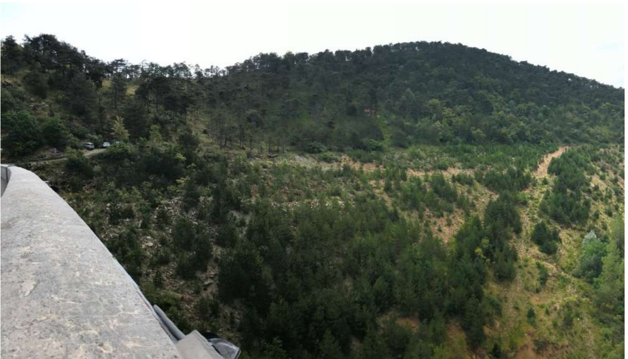
A10. 09/09/2021 – Coronamento e zona di monte in sponda destra.
