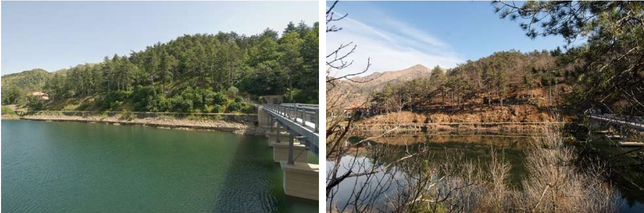
A sinistra: Condizioni rilevate nel corso delle precedenti procedure. A destra: Condizioni attuali.
