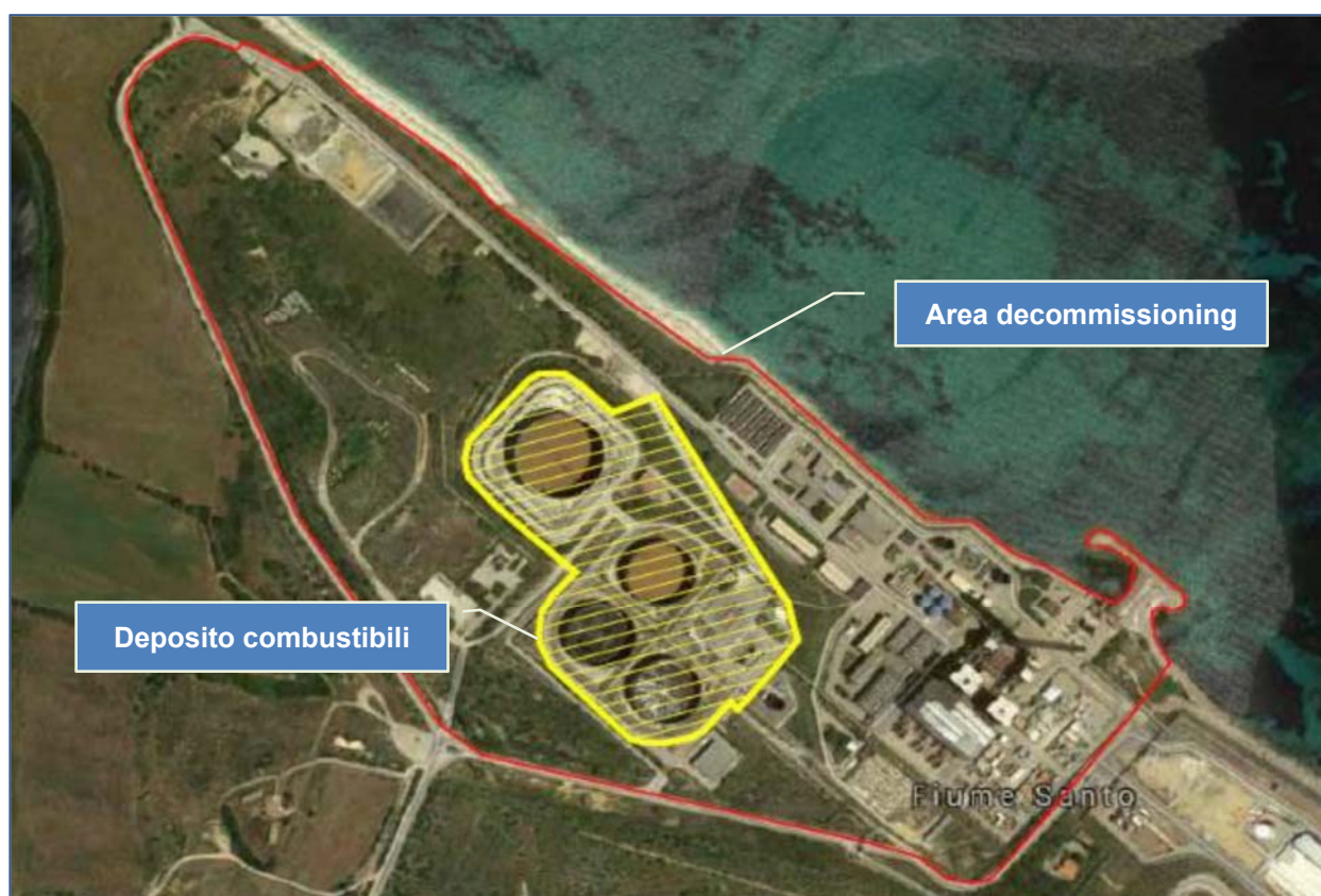
Veduta aerea del “Deposito Combustibili Liquidi”
