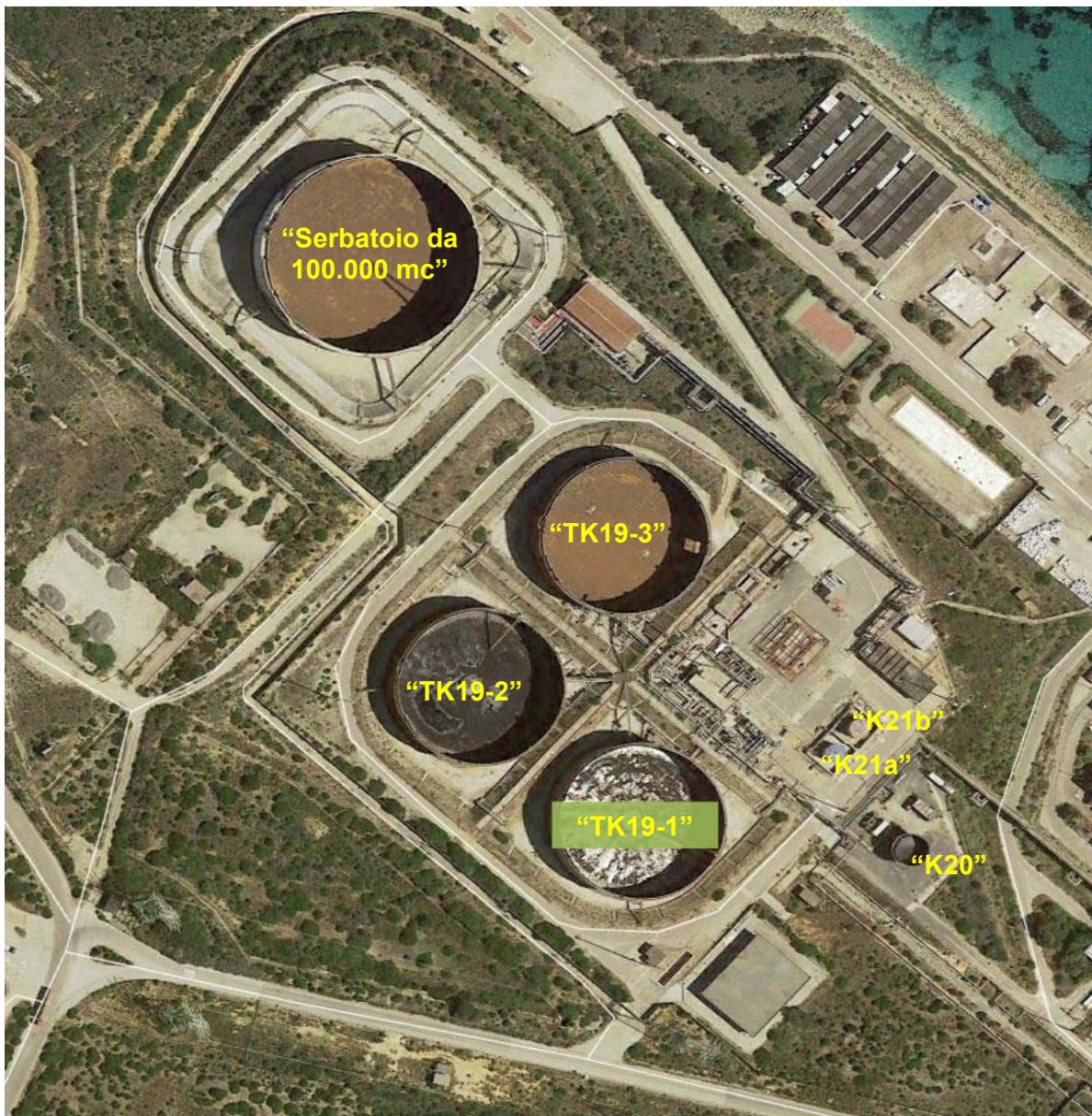
Veduta aerea del “Deposito Combustibili Liquidi”
