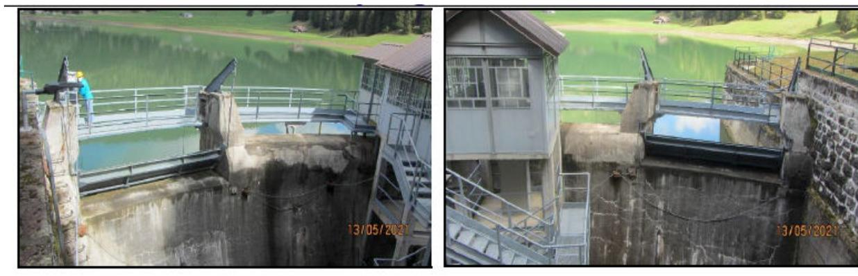
Figura 4 Luce destra e sinistra dello scarico principale presidiate da paratoia
