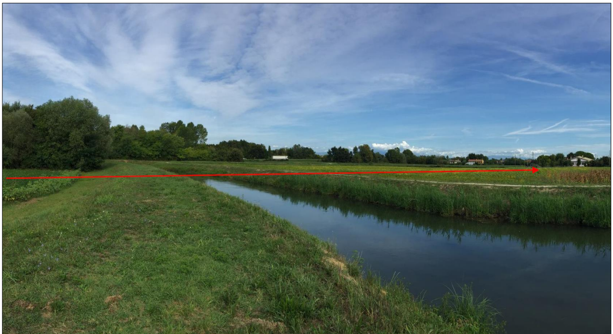
Figura 5-9: Vista del Fiume Tergola attraversato dalla condotta in progetto
