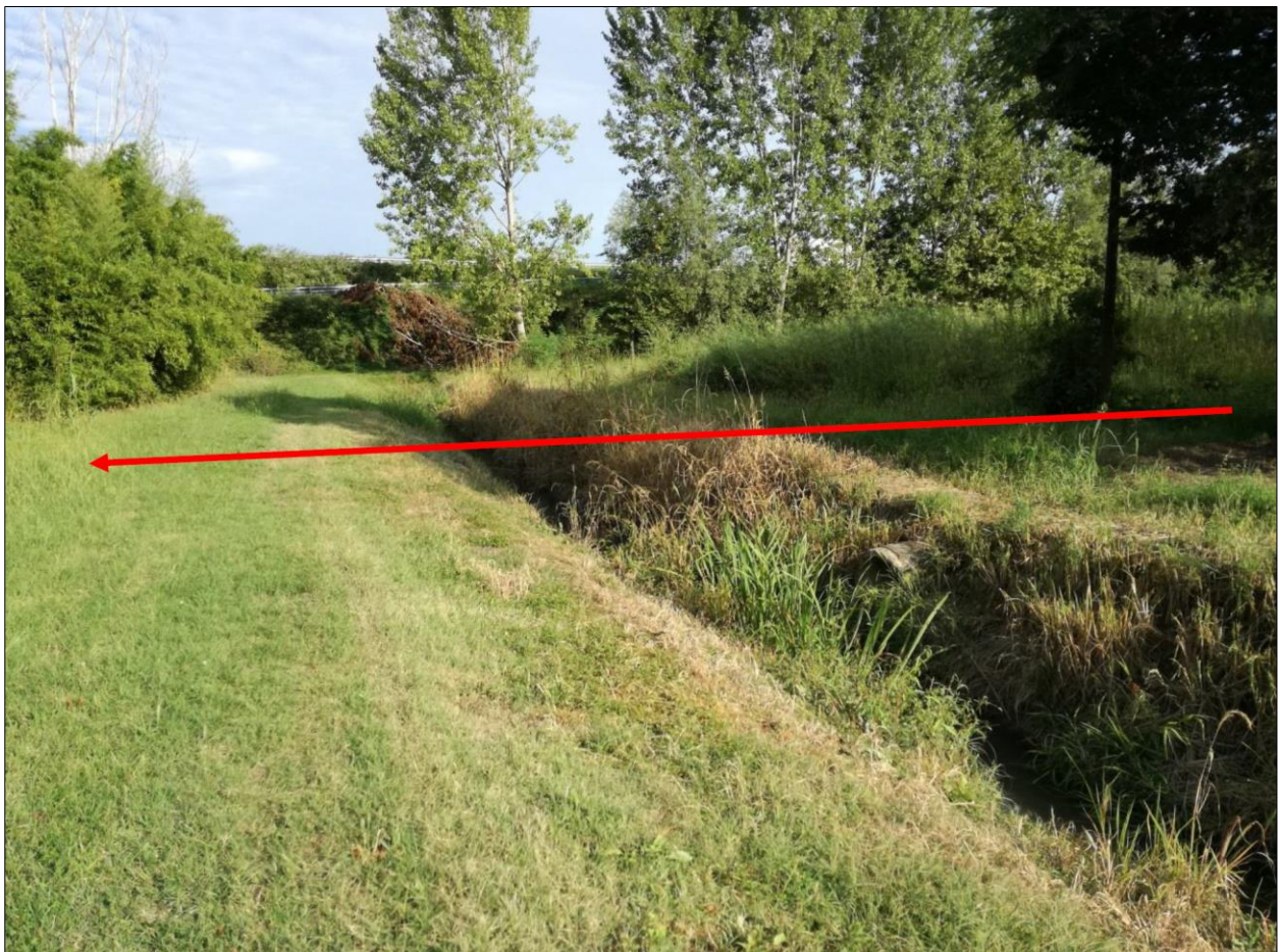
Figura 5-5: Vista del Fosso 1 di Camposampiero attraversato dalla condotta in progetto
