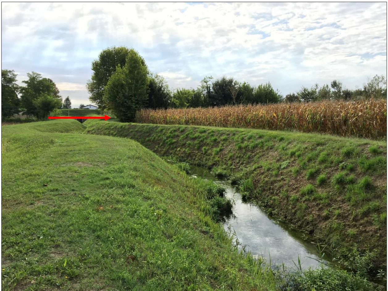
Figura 5-8: Vista della Fossetta Loreggiola attraversata dalla condotta in progetto
