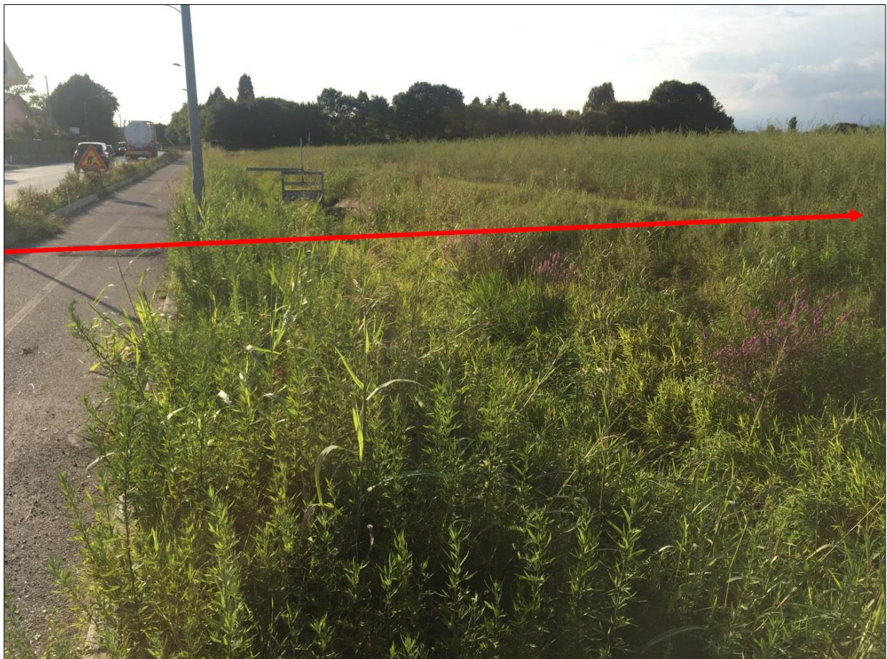
Figura 5-6: Vista del Fosso di Via Straelle attraversato dalla condotta in progetto
