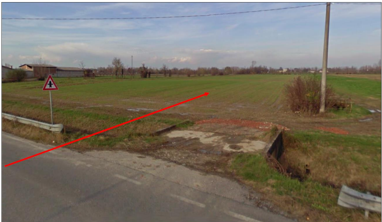
Figura 5-1: Vista dello Scolo Fiumicello attraversato dalla condotta in progetto
