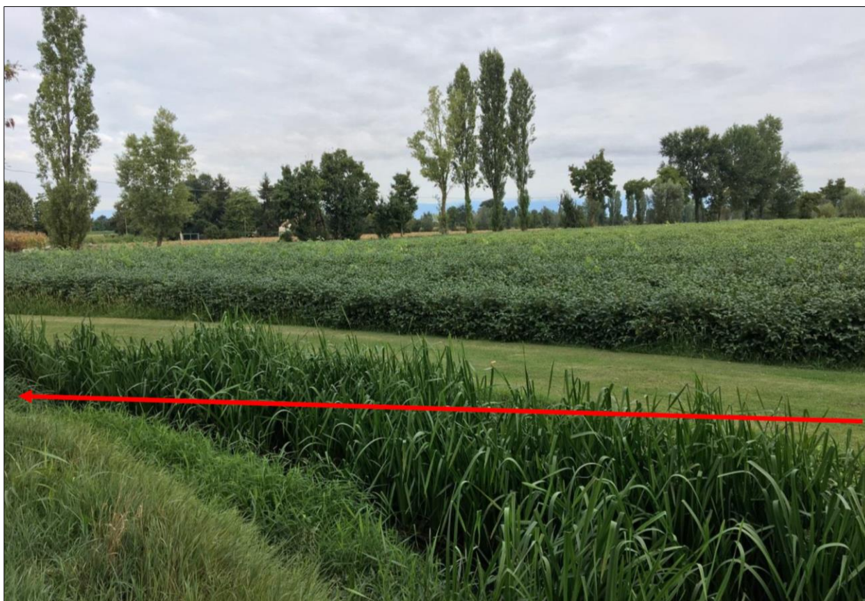
Figura 5-12: Vista della Fossetta Loreggiola attraversata dalla condotta in progetto
