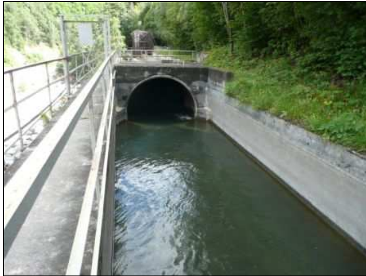
Figura 141 - Entrata in galleria
