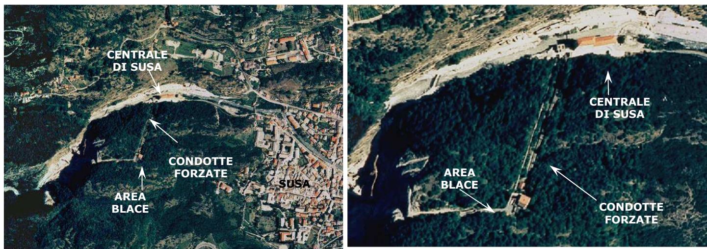
Figura 56 - Condotte forzate e centrale di Susa.
