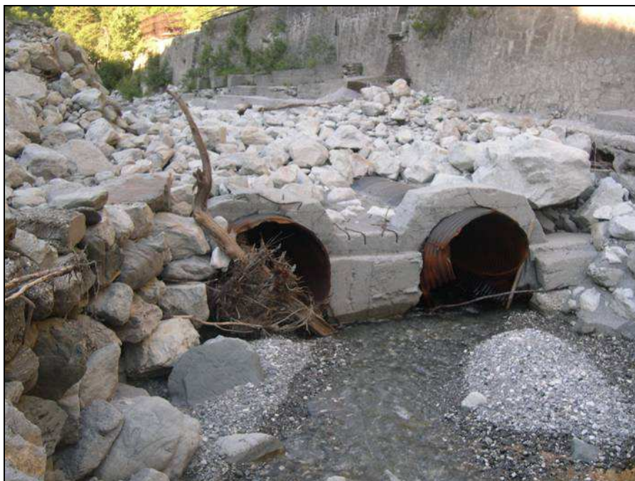
Figura 139 – Tubazioni in alveo per by-pass area di dissesto
