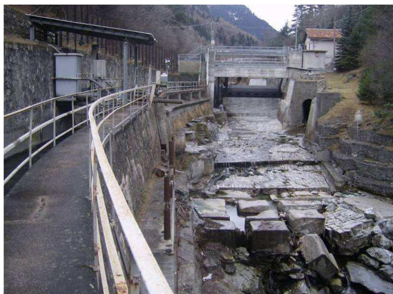
Opera di presa e inizio del canale di derivazione (sopra) Canale di derivazione (sotto) in un tratto a cielo aperto e in tubazione
