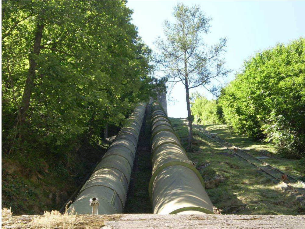
Figura 164 - Vegetazioni prossime alle condotte forzate
