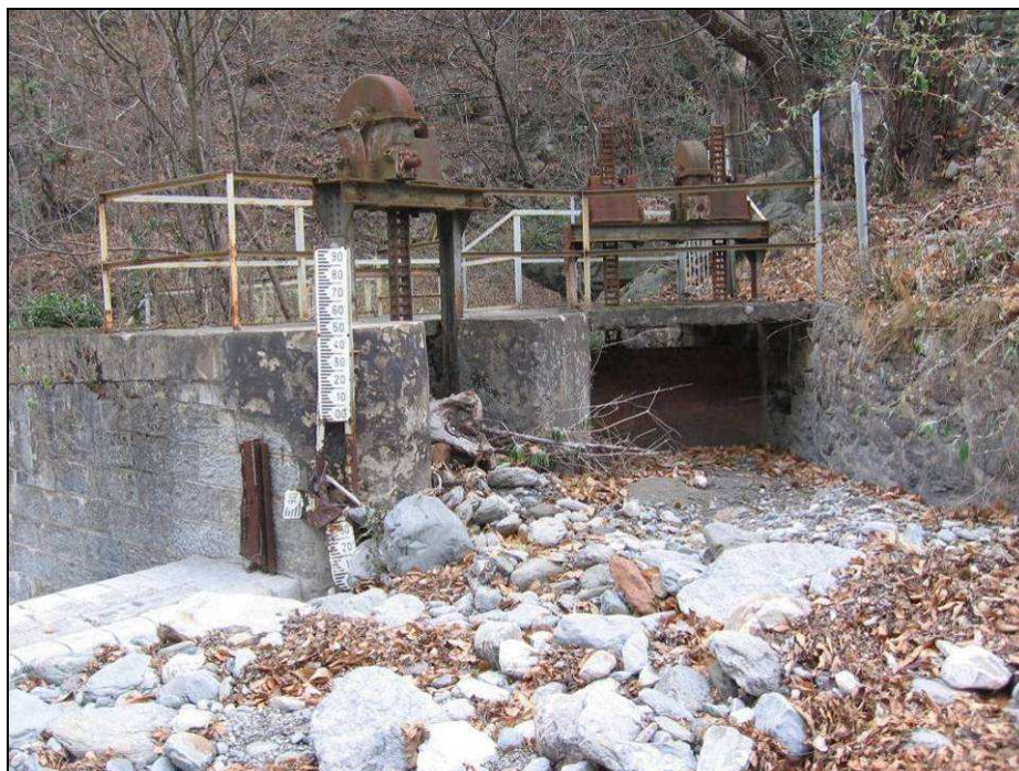
Figura 65 – Opera di presa Clarea Bassa
