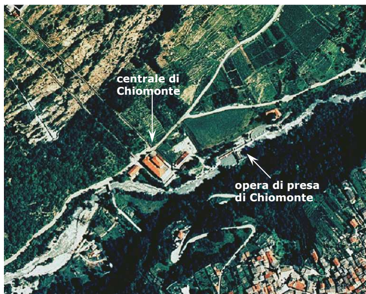
Figura 54 - Centrale di Chiomonte e opera di presa sulla Dora.
