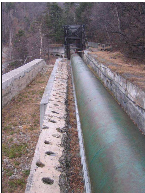
Figura 61 – Canale di derivazione a valle di Serre La Voute. Tratto in tubazione metallica nella zona del muro in cls
