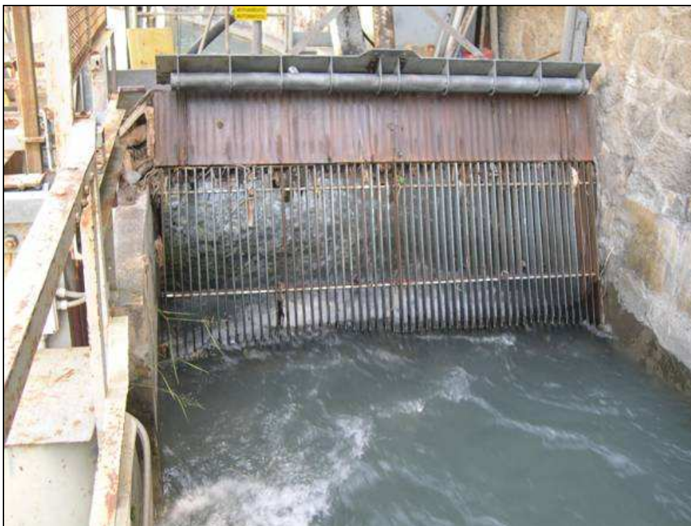
Figura 137 - Canale derivatore con griglia: si notino le elevate velocità di corrente
