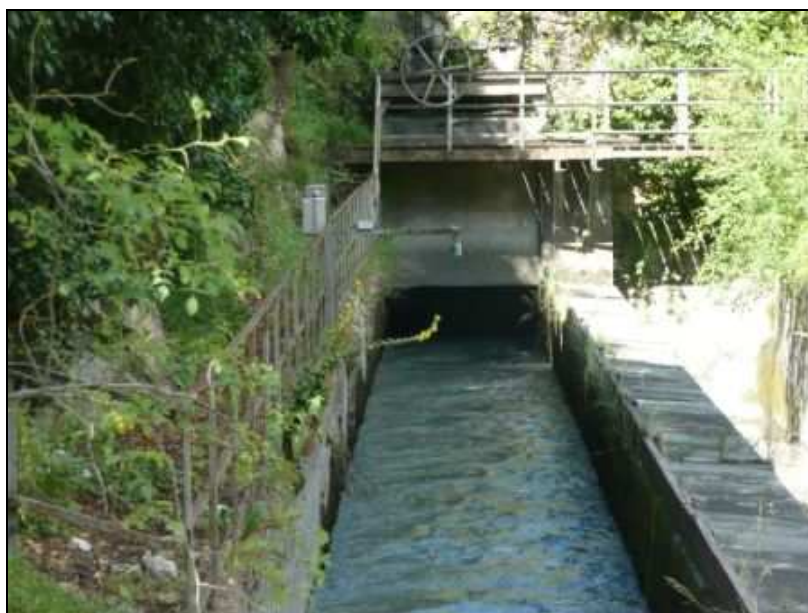
Figura 143 – Ingresso in galleria del canale derivatore
