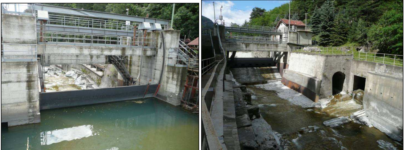
Figura 136 – Immagini dell'opera di presa di Serre La Voute. da monte (a sinistra) e da valle (a destra)
