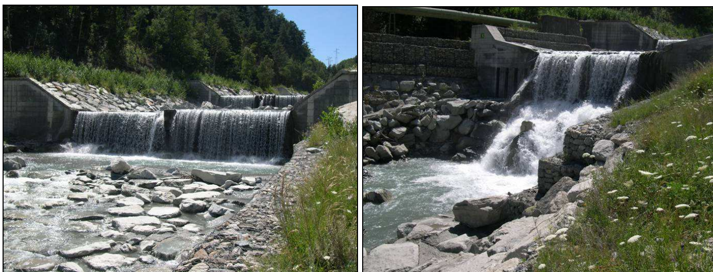
Figura 140 - Sequenza di briglie senza scale di risalita dei pesci poche centinaia di metri a valle della traversa di Serre la Voute
