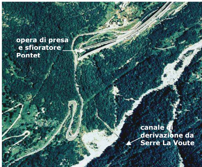
Figura 50 - Sfiatore Pontet e opera di presa
