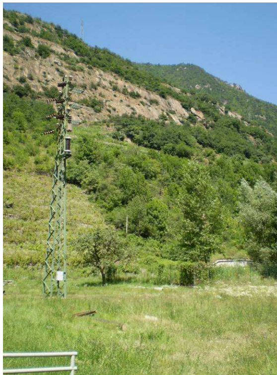
Figura 163 - Area di futura realizzazione della nuova centrale
