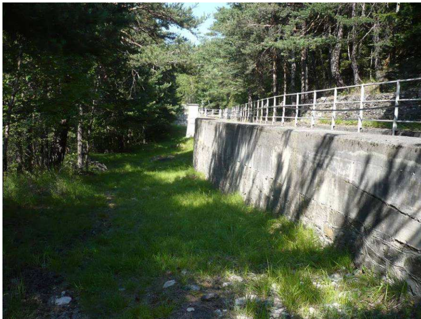
Figura 149 - Vegetazione dell'intorno del canale di derivazione
