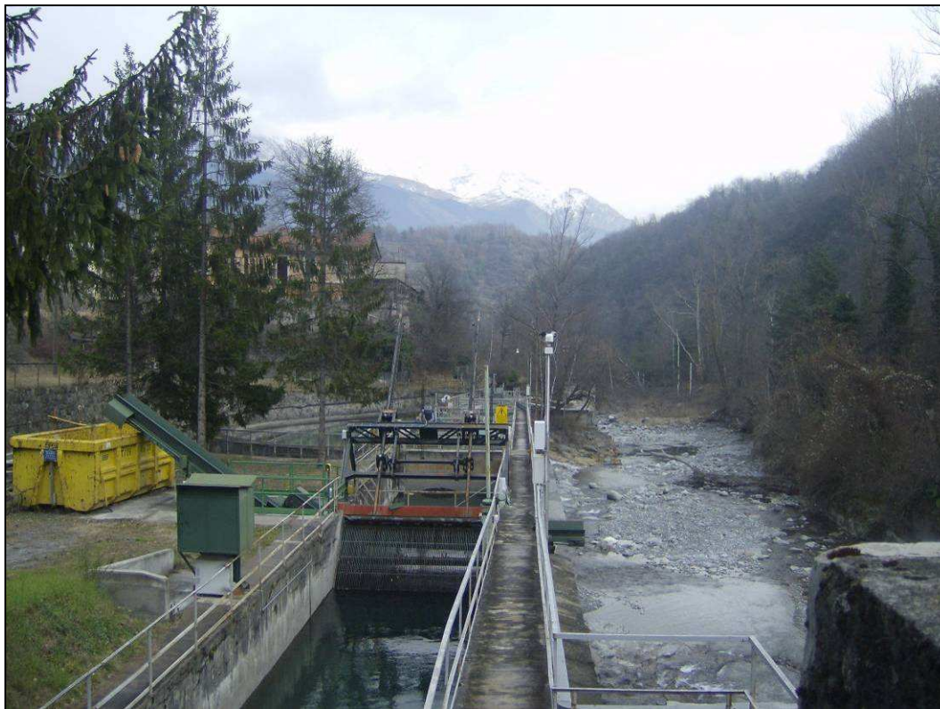
Figura 64 – Opera di presa di Chiomonte
