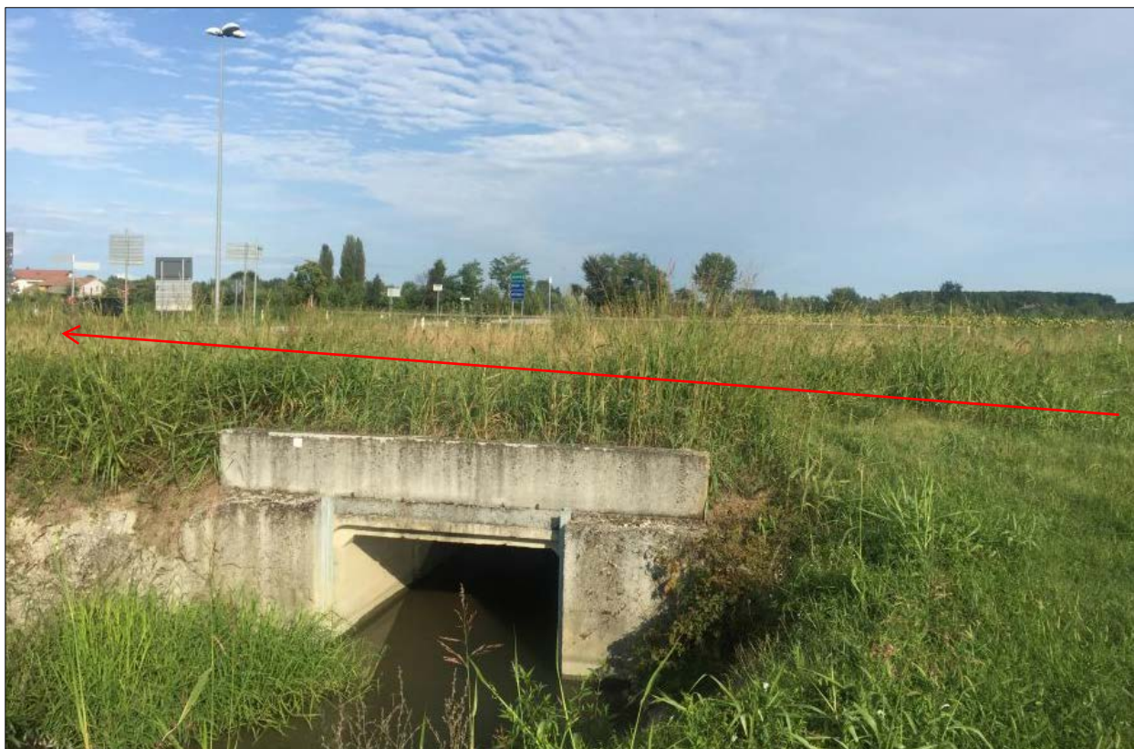
Figura 5-2: Vista del Fosso 1 Camposampiero, tombato attraversato dalla condotta in progetto
