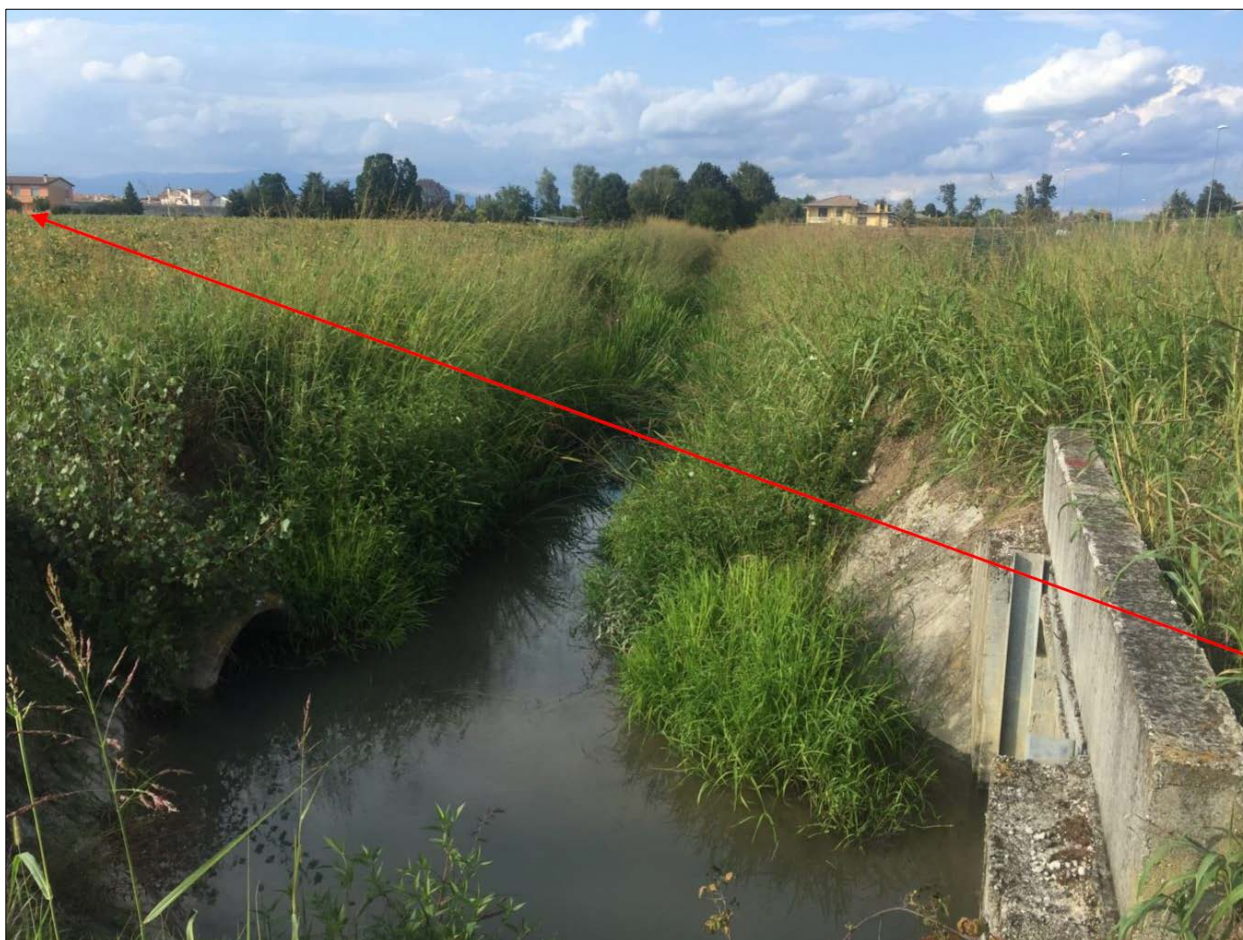
Figura 5-3: Vista del Fosso 1 Camposampiero attraversato dalla condotta in progetto
