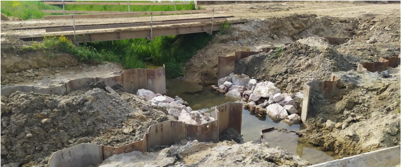
Fig. 2 – Particolare cantieristico dell'attraversamento Scolo Lusore (ASP02BO). Attraversamento mezzi con ponte volante e scavo di posa a larghezza ristretta.
