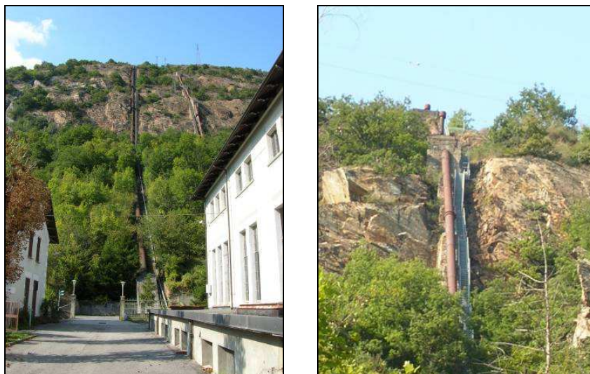
Figura 19 – Condotta forzata n°1-2 e di scarico a Chiomonte
