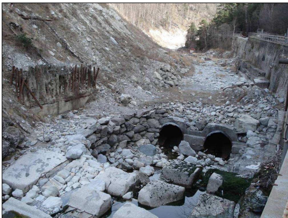
Figura 1 – Tratto di Dora Riparia con posa di doppia tubazione by-pass
