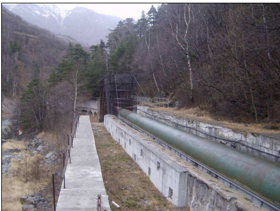
Figura 2 – Zona di realizzazione del nuovo dissabbiatore
