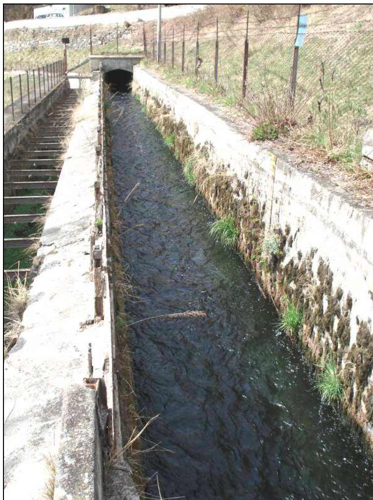
Figura 6 – zona di intervento sullo sfioratore Pontet
