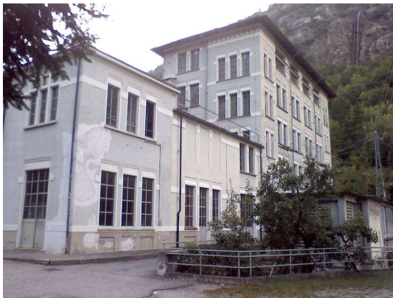
Figura 26 – dettagli delle finestre della centrale di Chiomonte riproposti nel nuovo fabbricato centrale
