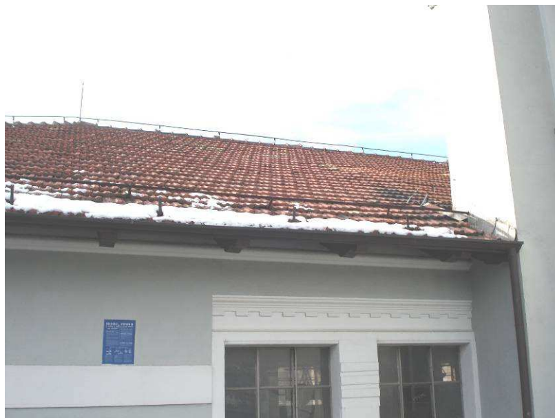
Figura 24 – dettagli della copertura della centrale di Chiomonte riproposti nel nuovo fabbricato centrale
