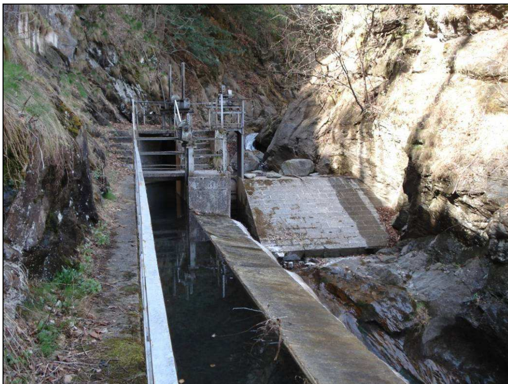
Figura 7 – zona di intervento sulla presa del rio Galambra
