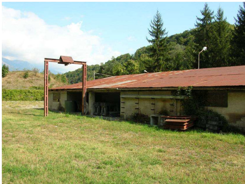
Figura 23 – capannoni esistenti in adiacenza alla centrale di Chiomonte da demolire
