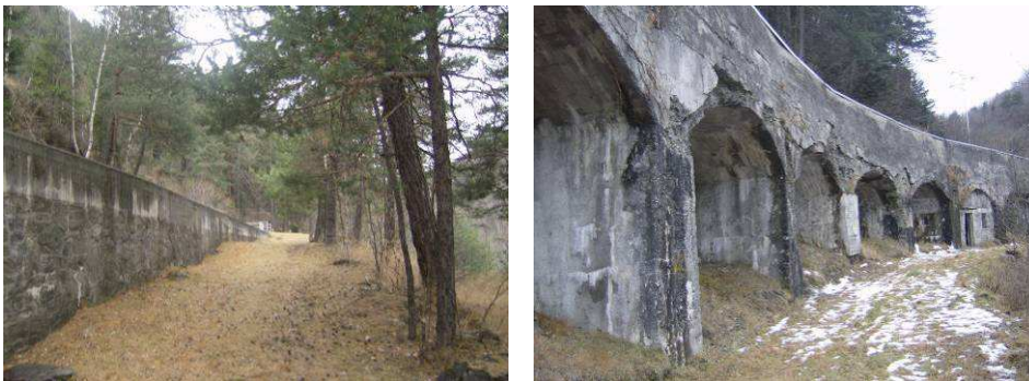
Figura 3: individuazione della pista di cantiere adiacente al canale di derivazione in destra idraulica
