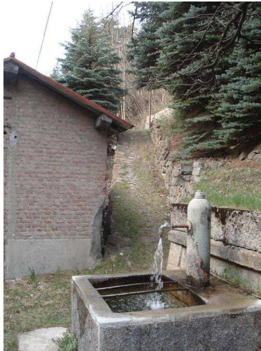
Figura 1: tratto terminale dell'esistente sentiero da adeguare per garantire l'accesso dei mezzi d'opera all'area dell'opera di presa
