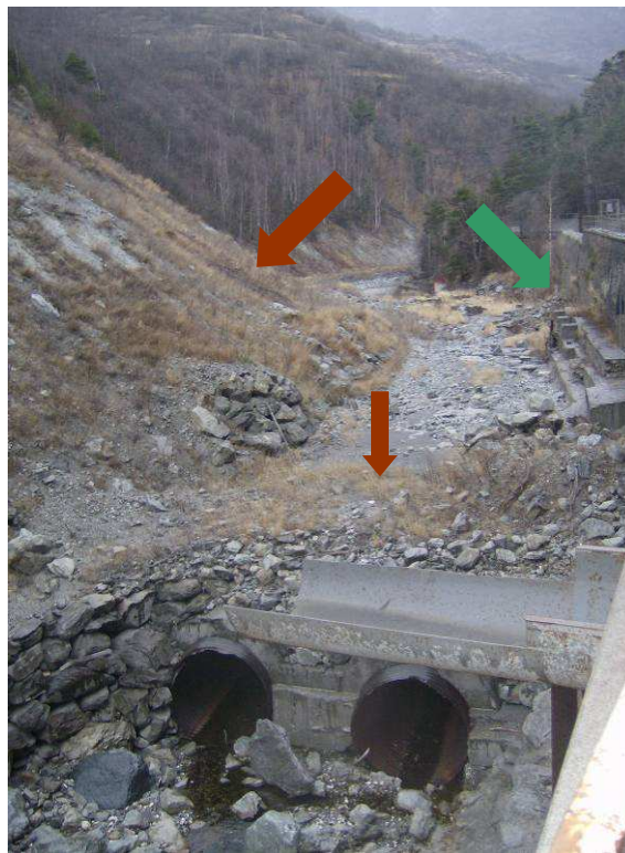
Figura 2: individuazione dei punti di discesa ed accesso alle aree di intervento sul versante destro
