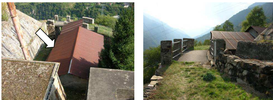
Figura 10: Edificio da demolire in loc. Ramat e spazi disponibili per la movimentazione d i piccoli mezzi d'opera
