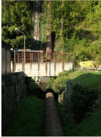
Figura 21: linee elettriche interferenti nel tratto terminale della condotta forzata n°3
