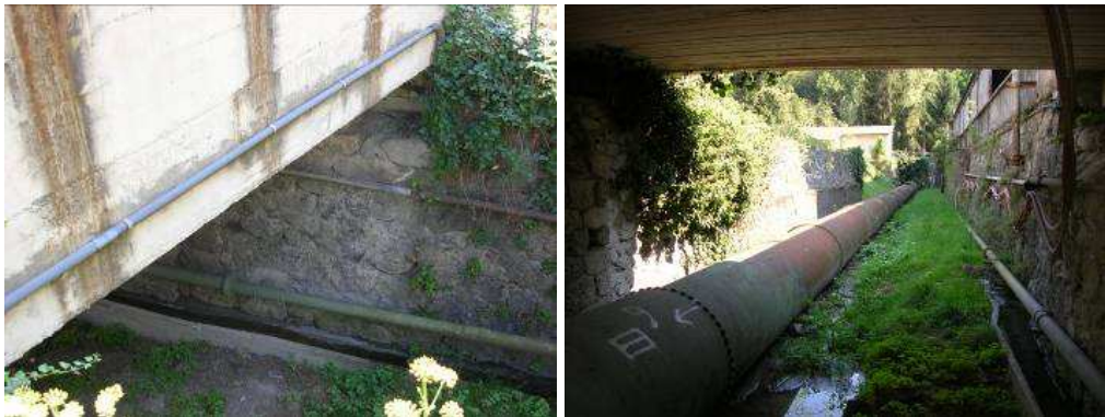
Figure 15 – 16: linee elettriche interferenti nel tratto terminale della condotta forzata n°3
