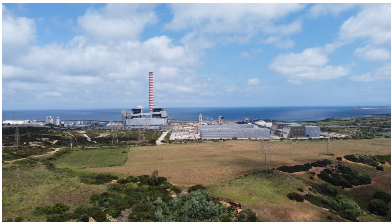
Figura 7.5 – Sito di ubicazione della sottostazione elettrica, immediatamente prospiciente la centrale termoelettrica di Fiume Santo
