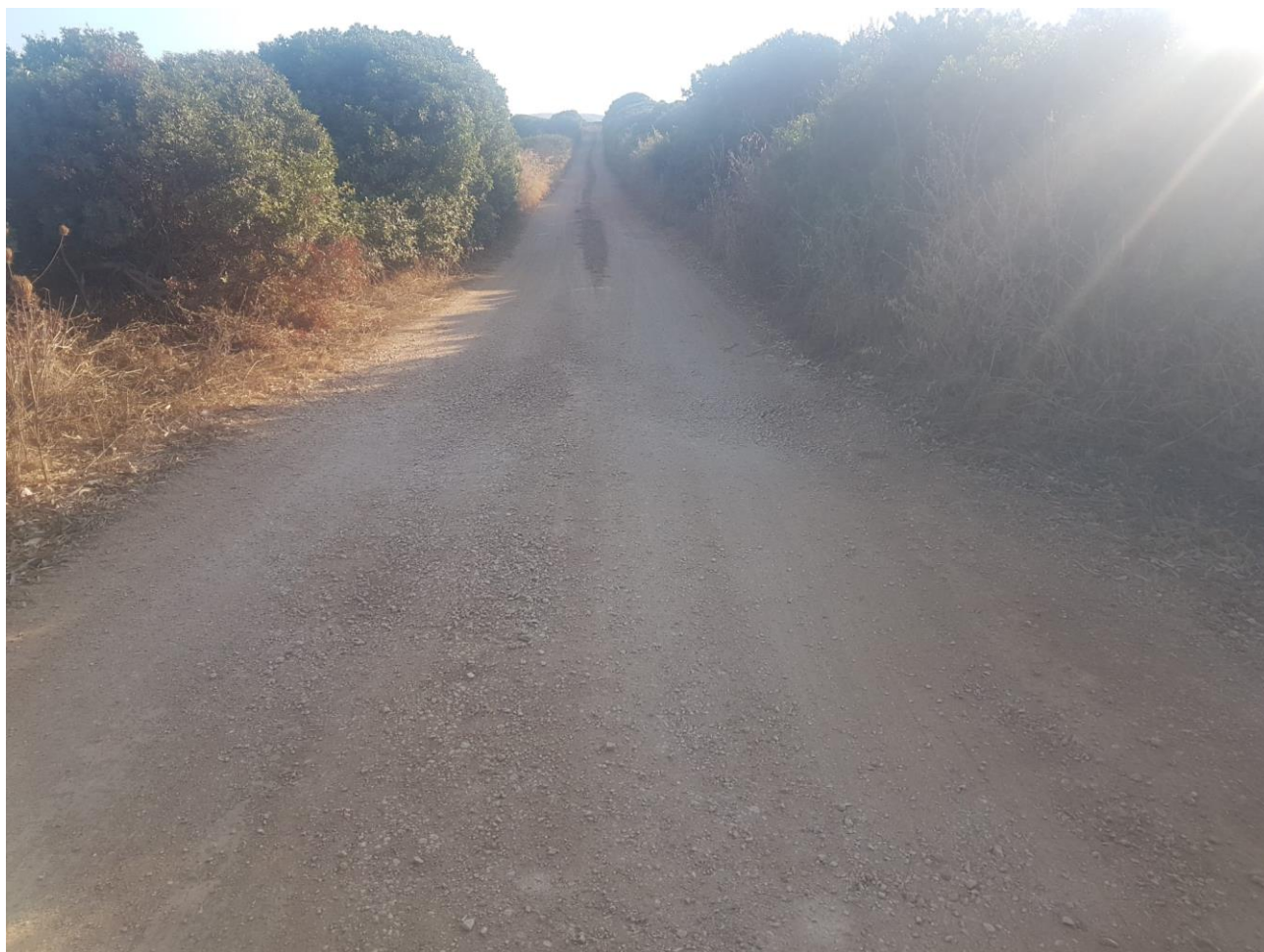
Figura 5.22 – Cavidotto V tratto.
