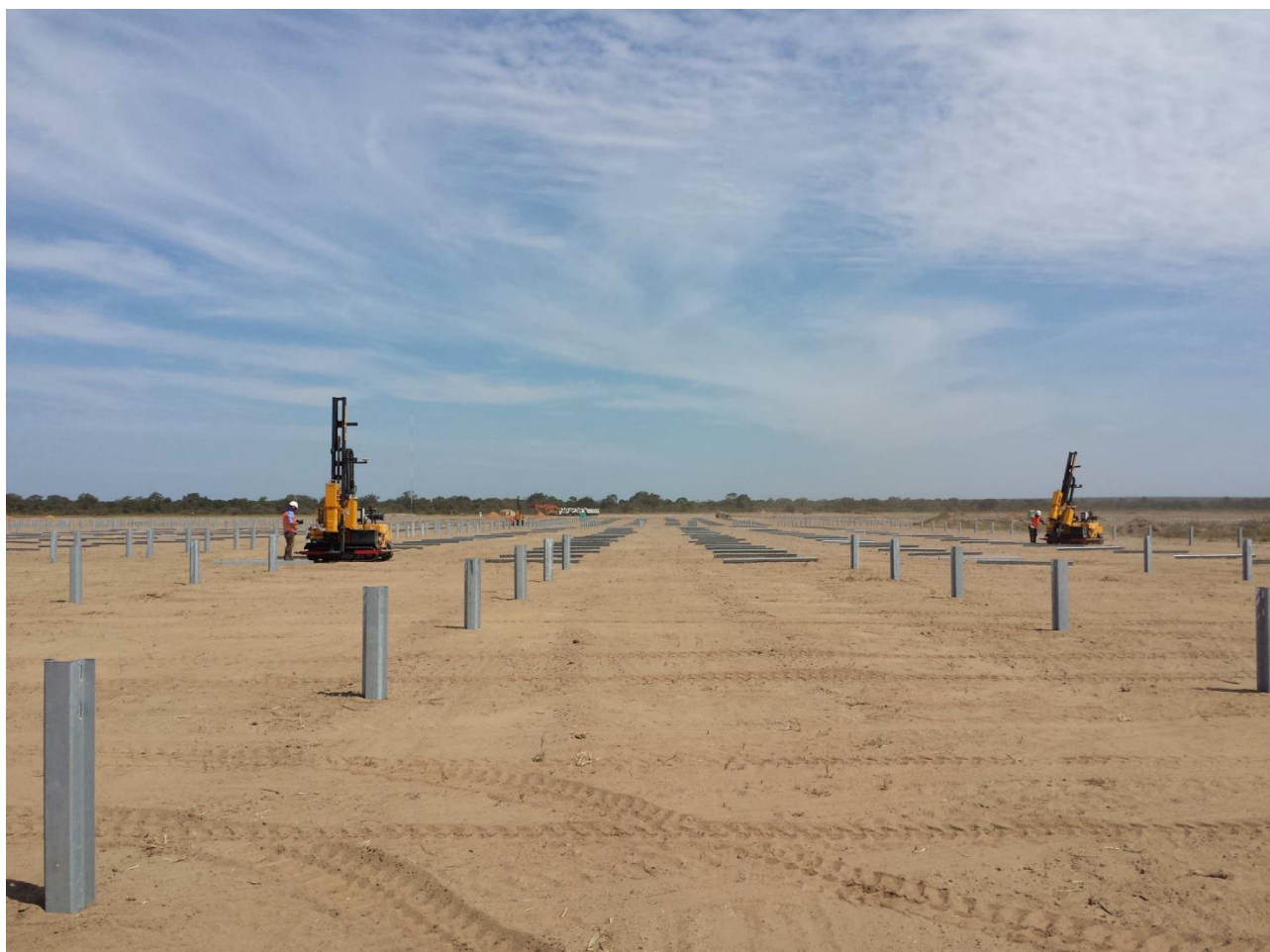
Figura 7.2 – Fase di infissione dei pali con profilo omega (fonte Convert)
