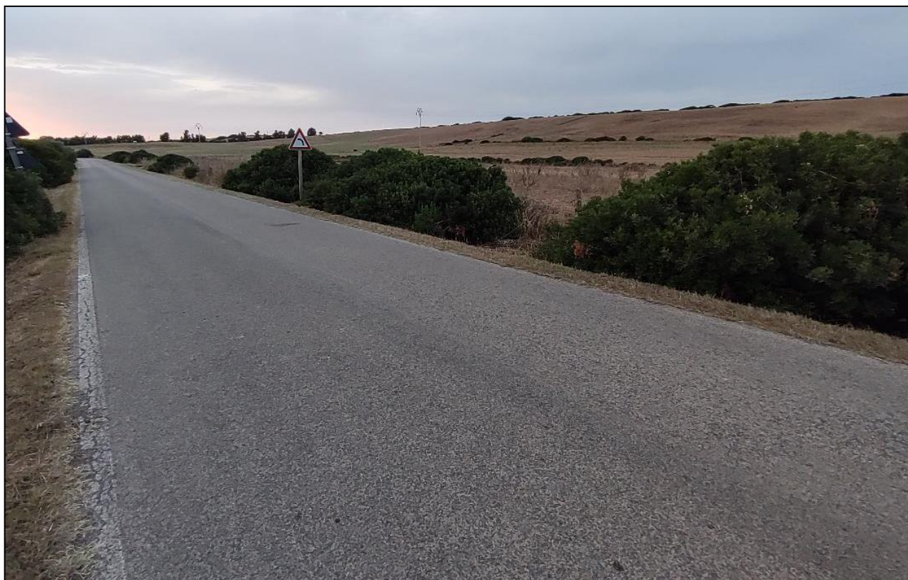
FOTO 2.3 – Settore centrale collinare di S'Eligheddu, terzo segmento rettilineo (da est verso ovest) della S.P. 34, intercettato nel settore di progetto.
