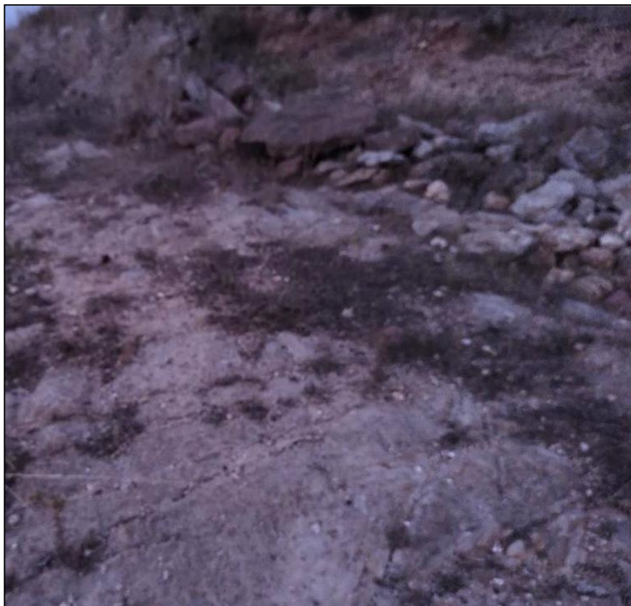
FOTO 2.6 – Settore con evidenza di spietramento e scarificazione superficiale di banchi conglomeratici.
