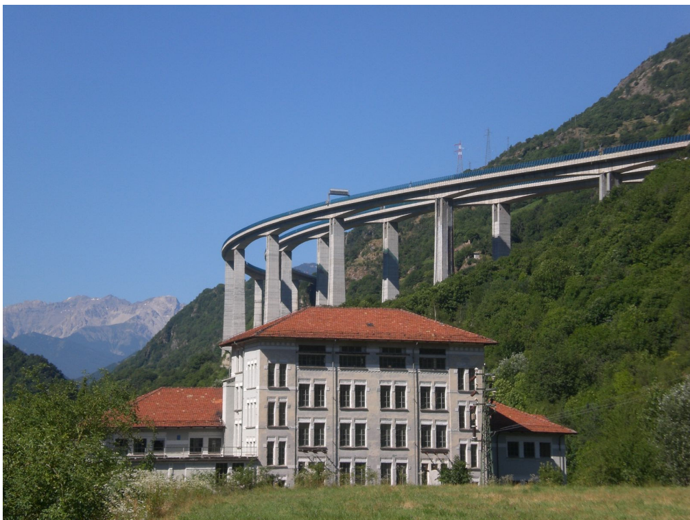
SITO N.11 – CENTRALE DI CHIOMONTE – Vista da Punto 4
