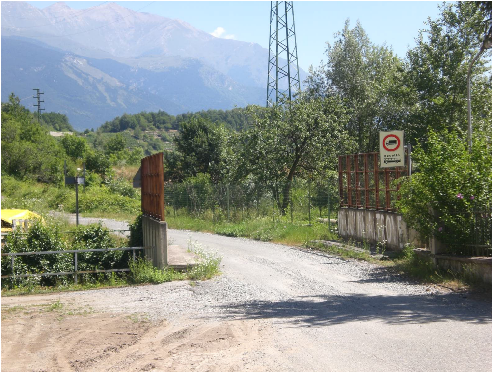
SITO N.11 – CENTRALE DI CHIOMONTE – Punto 7
