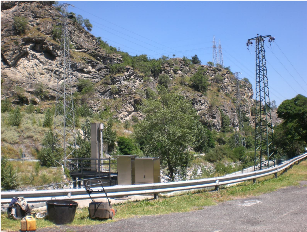
SITO N.01 – CENTRALE DI SUSA – PRESA ENEL
