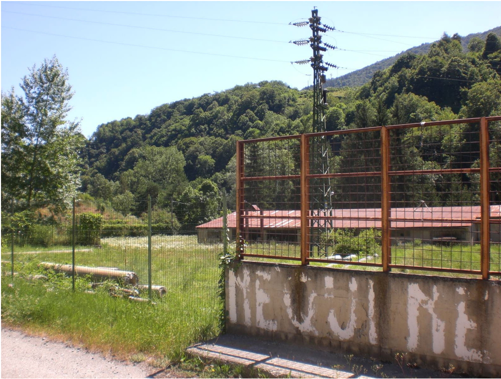
SITO N.11 – CENTRALE DI CHIOMONTE – AREA NUOVA CENTRALE (Vista da Punto 7)
