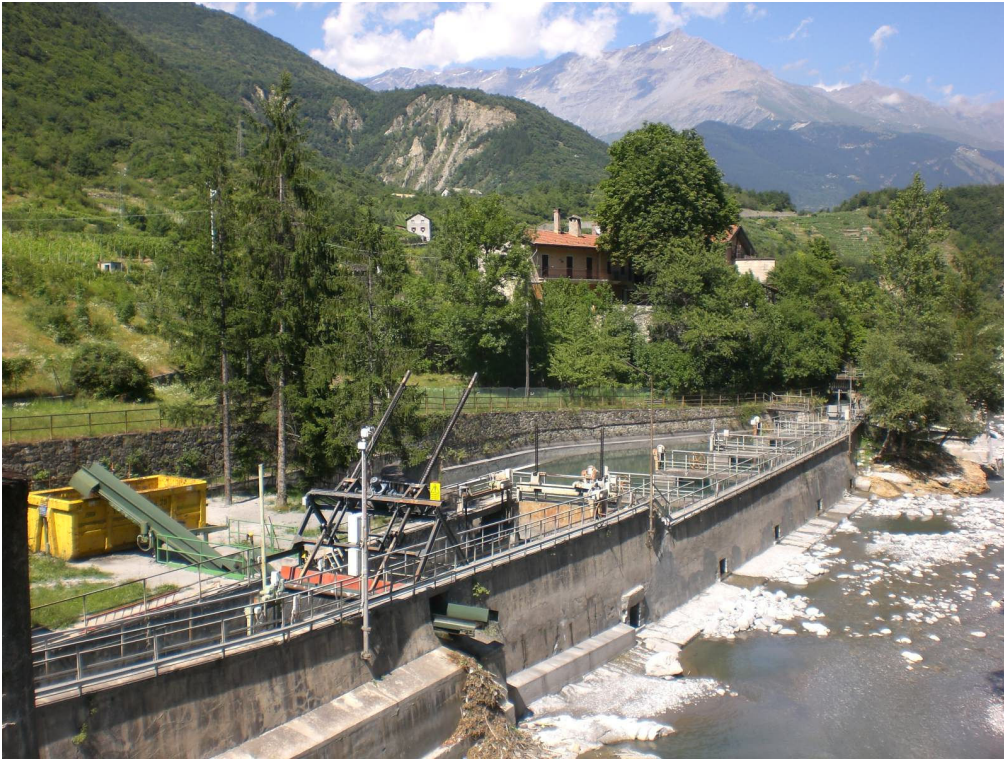
SITO N.12 – PRESA DI CHIOMONTE – GRIGLIA E DISSABBIATORE, RICETTORE R6
