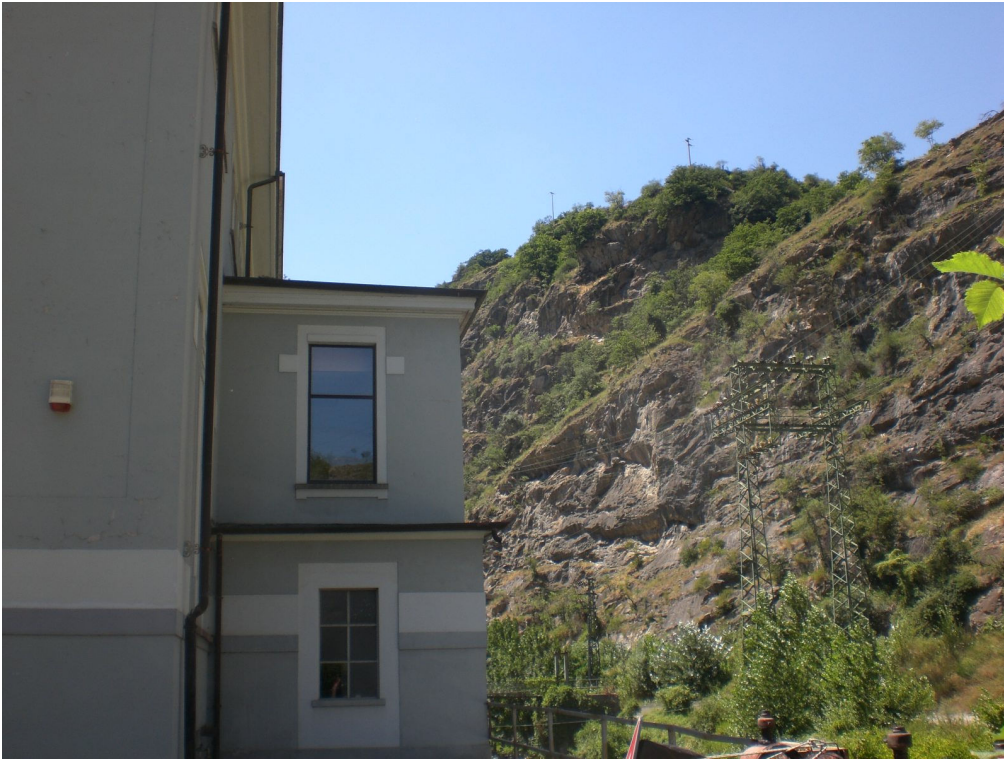
SITO N.01 – CENTRALE DI SUSA – FABBRICATO TURBINA
