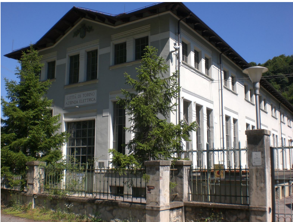
SITO N.11 – CENTRALE DI CHIOMONTE – EDIFICIO VECCHIA CENTRALE
