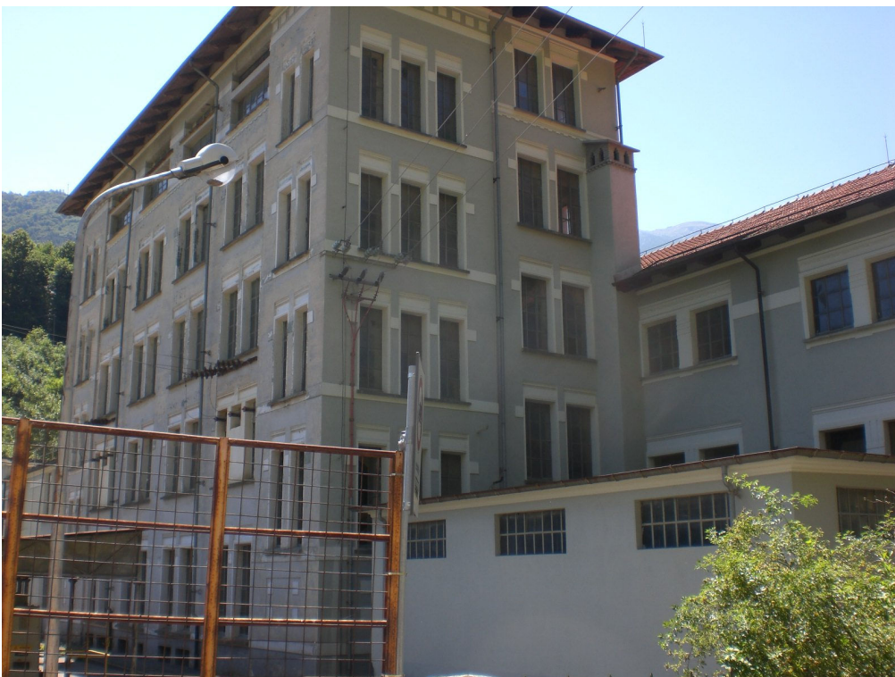
SITO N.11 – CENTRALE DI CHIOMONTE – EDIFICIO VECCHIA CENTRALE (Vista da Punto 7)
