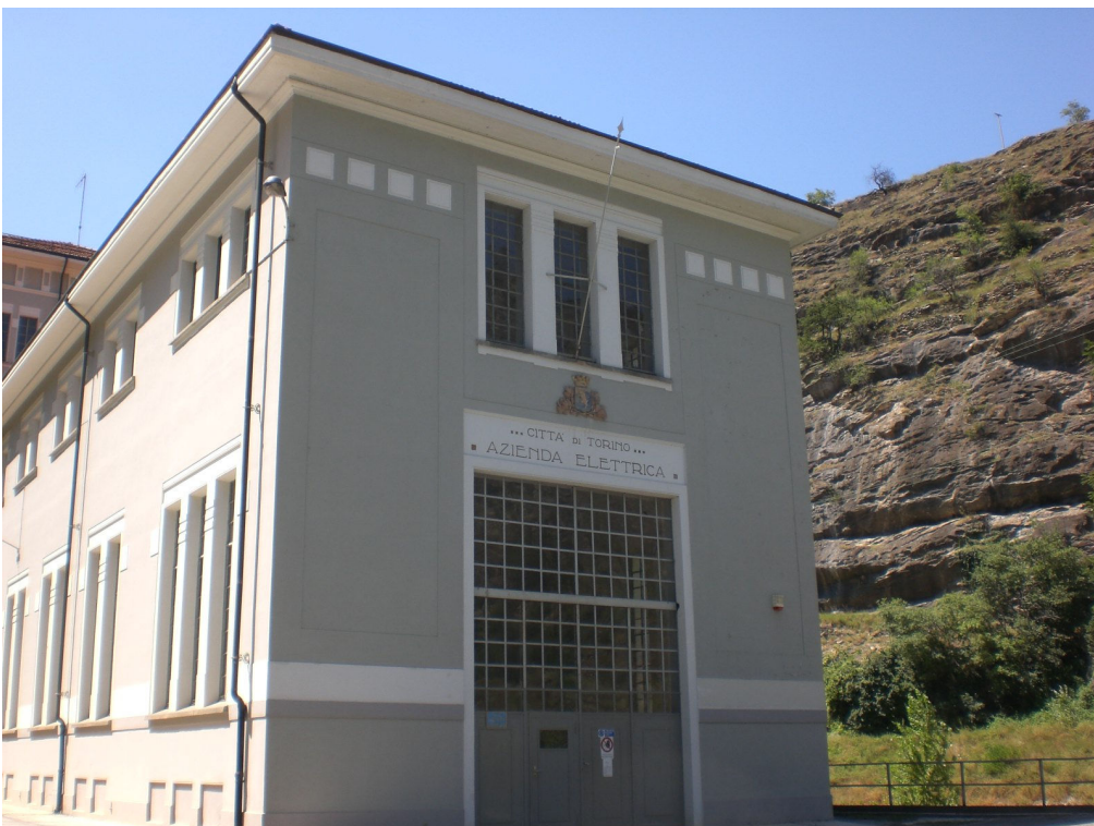
SITO N.01 – CENTRALE DI SUSA – FABBRICATO TURBINA
