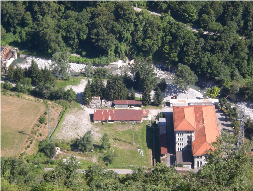
SITO N.10 – NODO IDRAULICO RAMAT – VISTA SITO N.11
