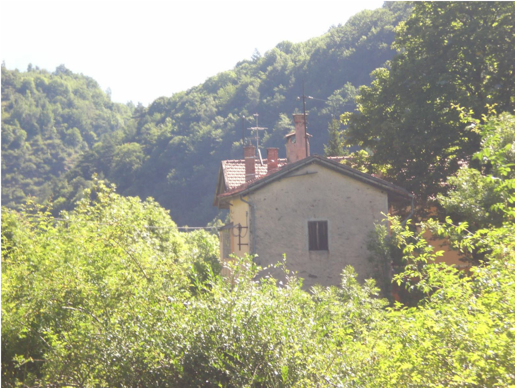
SITI NN.11,12 – CENTRALE E PRESA DI CHIOMONTE – RICETTORE R6 (Vista da Punto 4)
