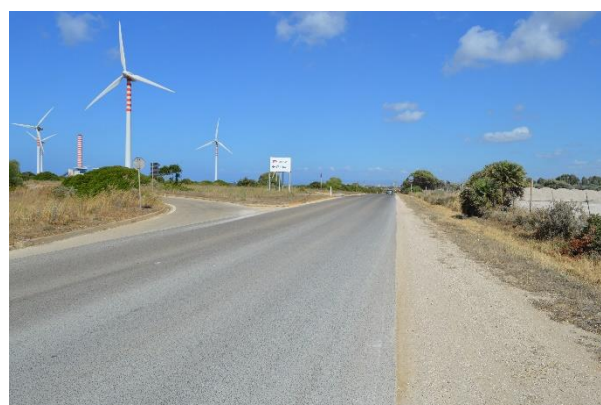
Figura 3.50 - Strada Provinciale 57 sede di posa del cavidotto MT
