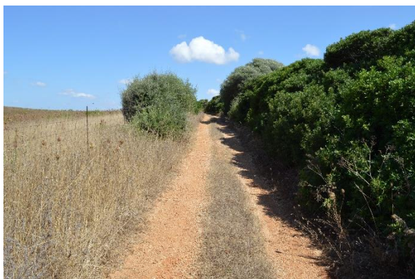
Figura 3.75 - Sterrato da adeguare per l'accesso all'ingresso 4 e 5. Tratto intermedio
