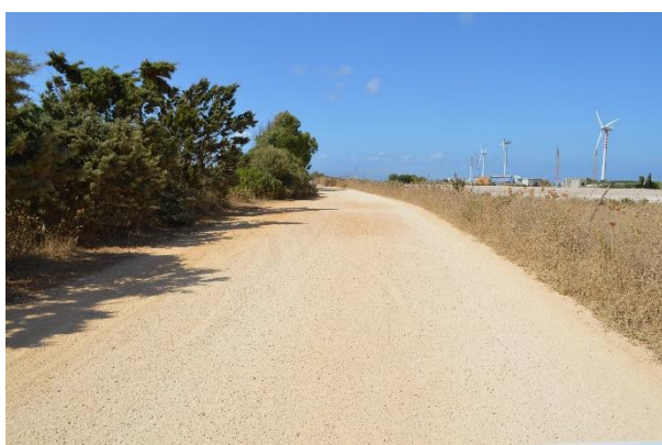
Figura 3.49 - Sterrato sede di posa del cavidotto MT, costeggiato da vegetazione erbacea nitrofila ed alberature artificiali di specie alloctone
