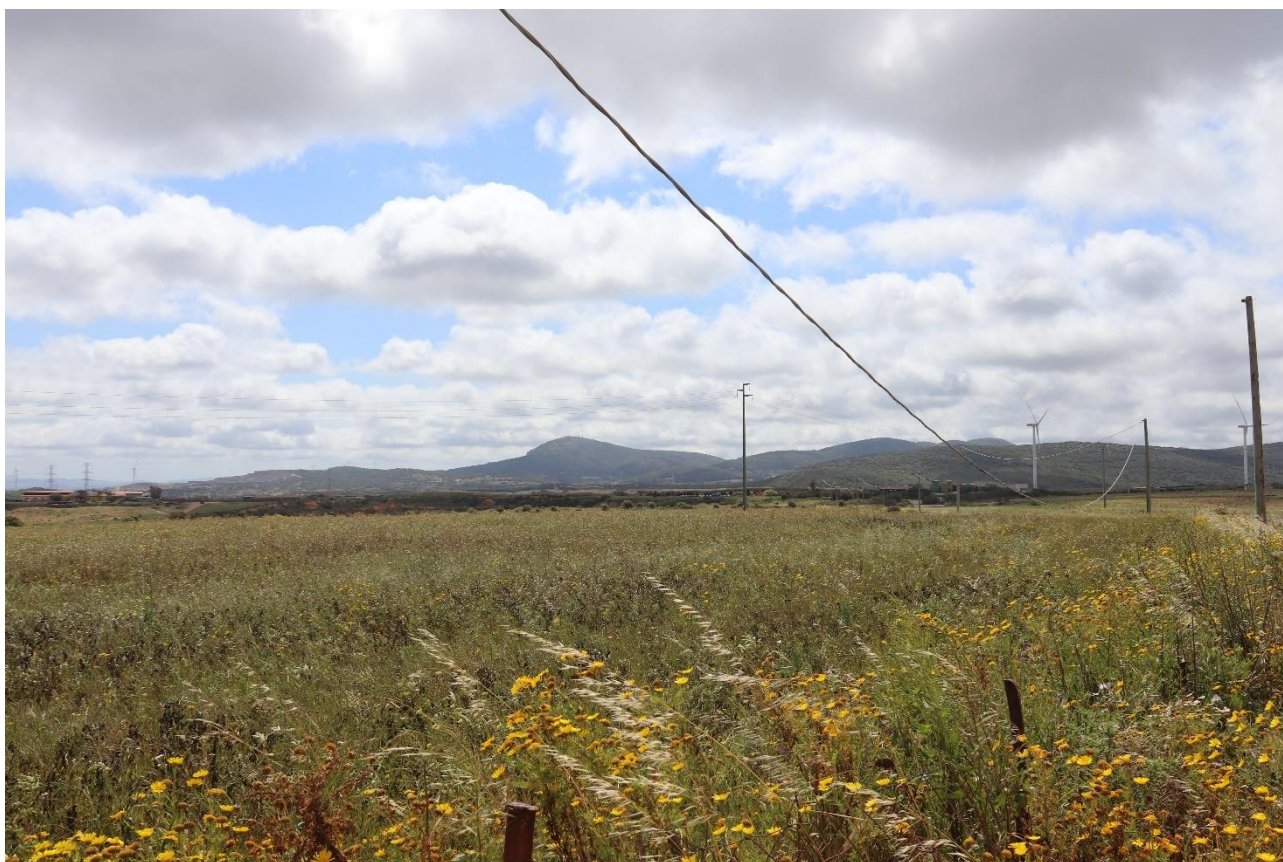
Figura 1.4 – Vista degli impianti eolici dalla parte centro orientale del lotto di progetto
