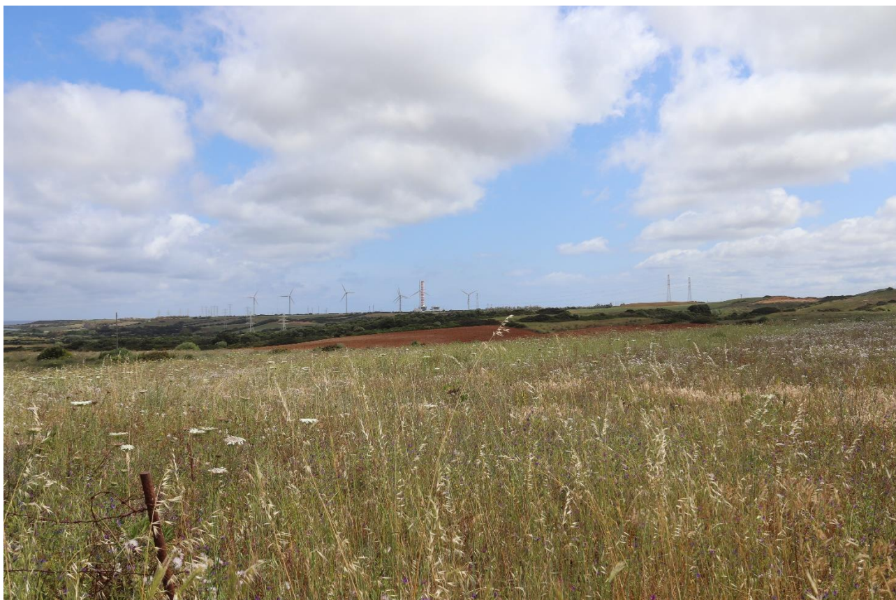
Figura 1.3 – Vista della centrale di Fiume Santo
