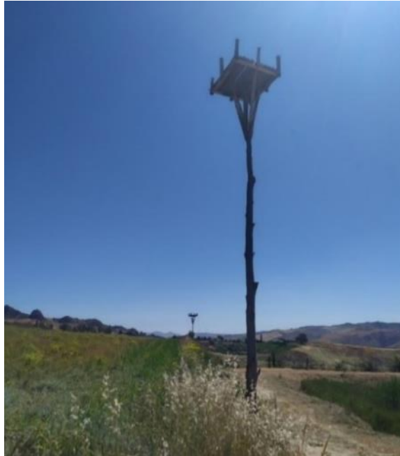
Figura 5.2/D - Esempio di palo in legno infisso al suolo per cicogna bianca
