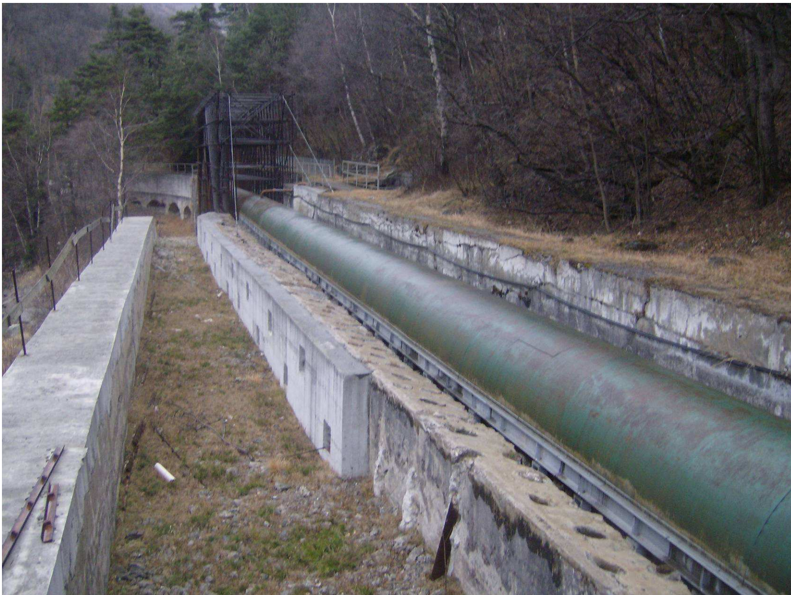
Figura 50 – zona vecchio dissabbiatore e tratto canale di derivazione in tubazione
