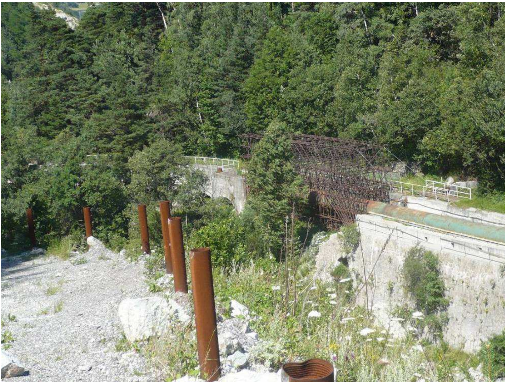
Figura 48 – Serre La Voute: tubazione metallica e ponteggio esistenti
