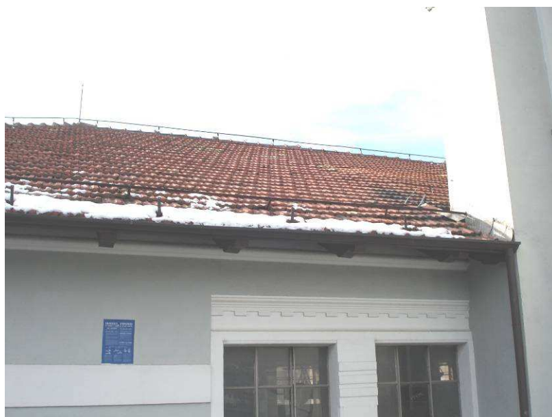
Figura 34 – dettagli della copertura della centrale di Chiomonte riproposti nel nuovo fabbricato centrale
