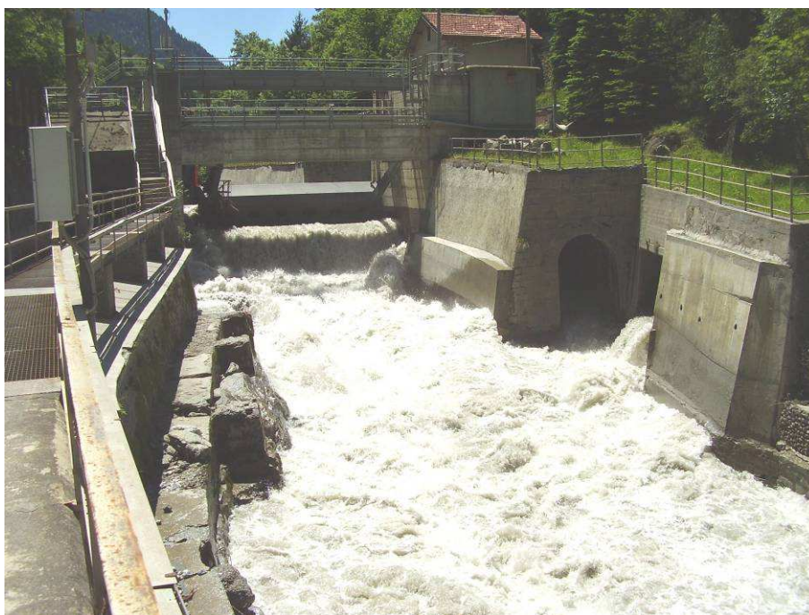
Figura 20 – Traversa di derivazione il loc. Serre la Voute e tratto iniziale del canale in sponda destra oggetto di riqualificazione
