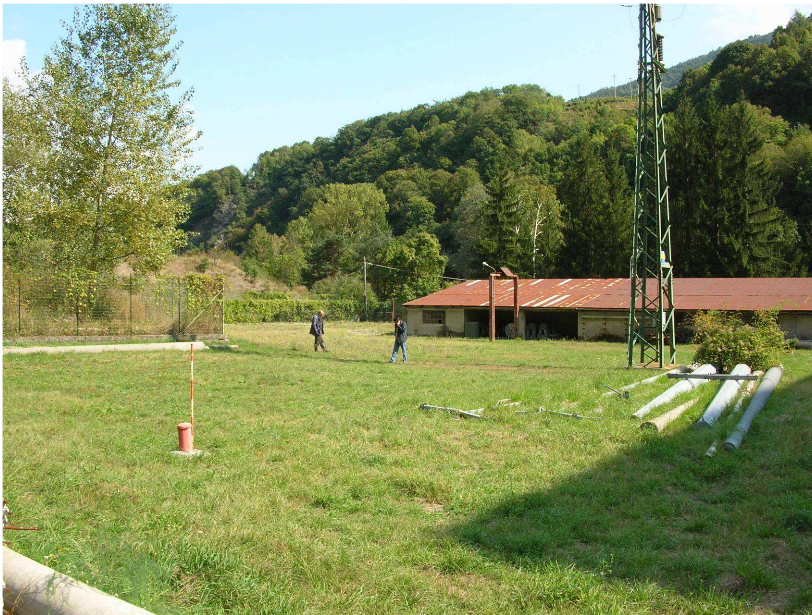
Figura 60 – area adiacente fabbricato centrale di Chiomonte – stato di fatto
