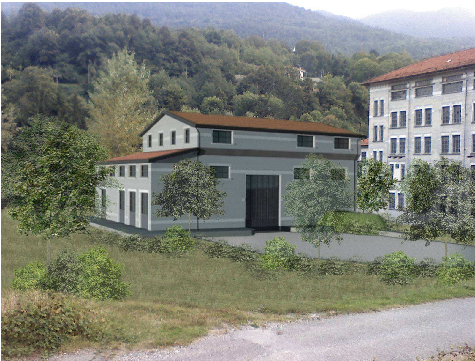
Figura 59 – area Centrale di Chiomonte – nuova centrale con vista da strada per Giaglione
