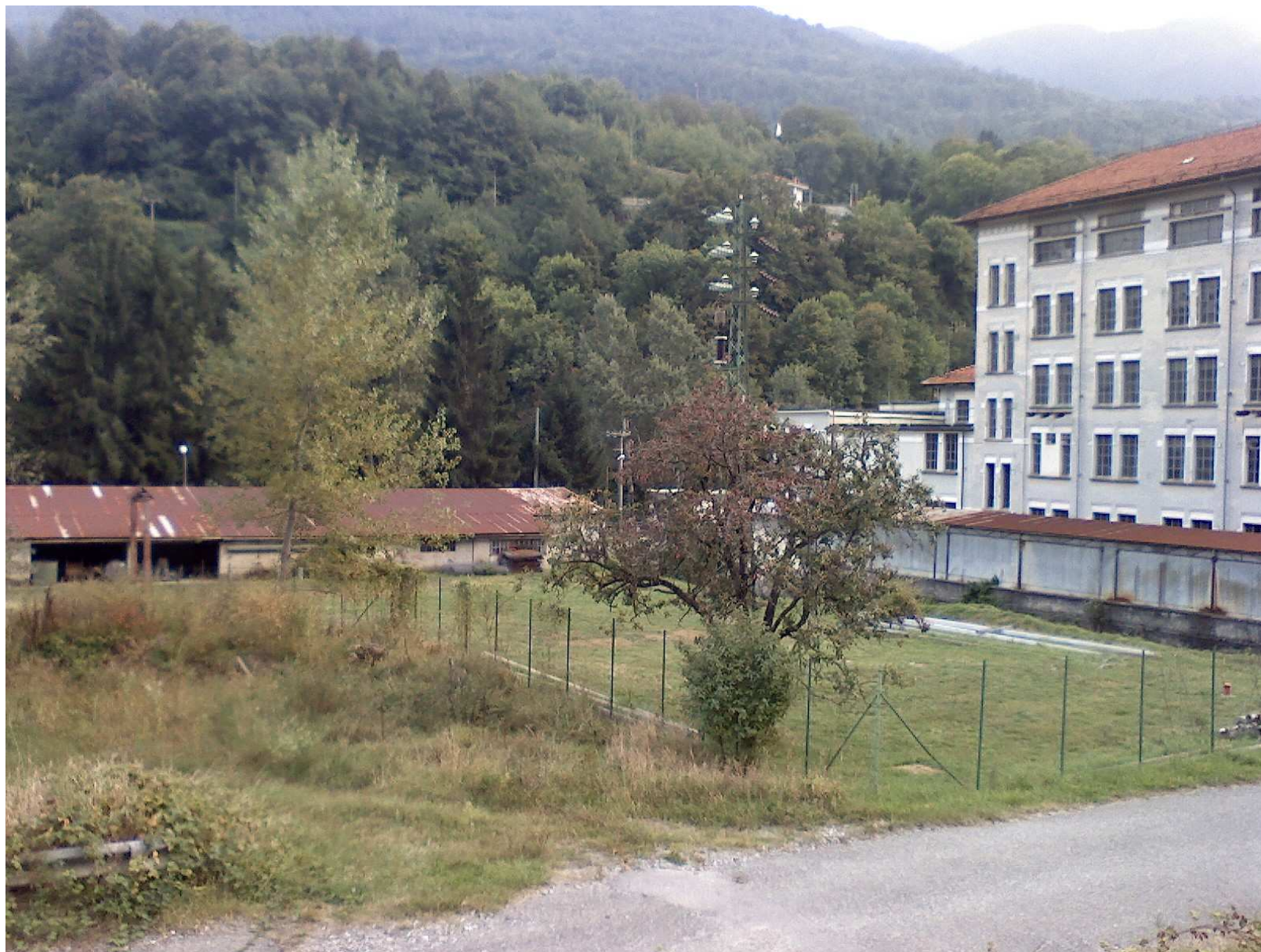
Figura 58 – area Centrale di Chiomonte – stato di fatto con vista da strada per Giaglione
