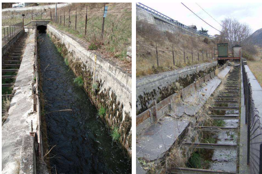
Figura 26 – manufatto sfioratore Pontet oggetto di riqualificazione strutturale e funzionale
