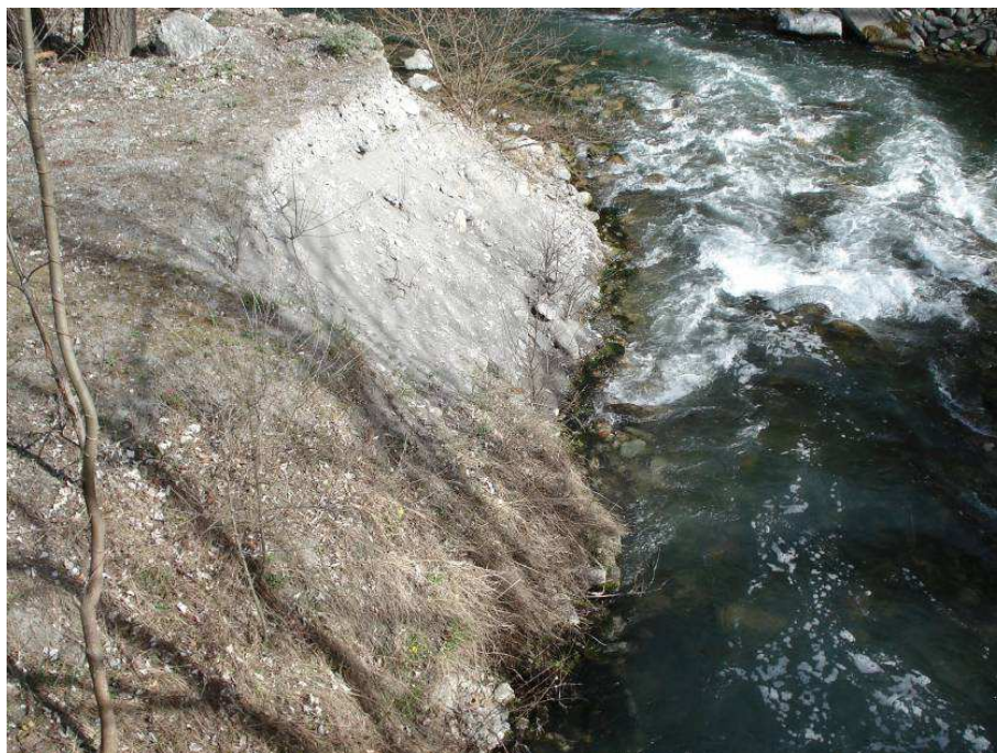
Figura 39 – scarico delle portate turbinate dalla centrale di Chiomonte nell'alveo della Dora Riparia in sponda sinistra idrografica
