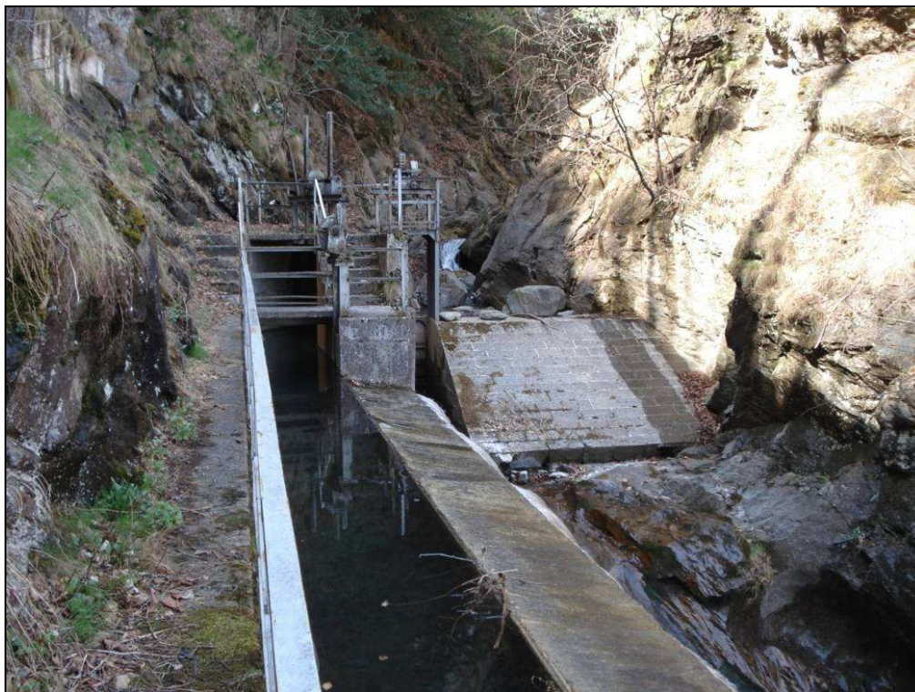
Figura 27 – zona di intervento sulla presa del rio Galambra
