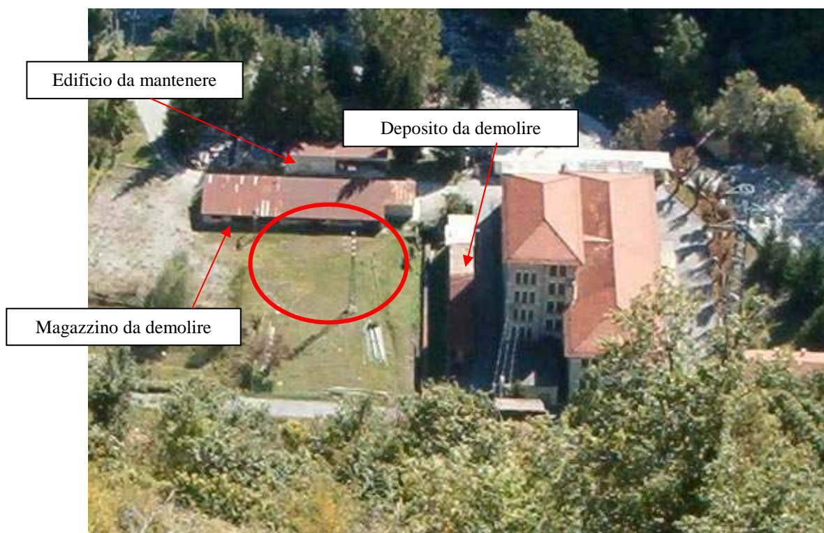
Figura 33 - Panoramica dell'area in cui sarà realizzata la nuova centrale. È visibile l'attuale centrale da dismettere e l'attiguo prato in cui sorgerà la nuova struttura
