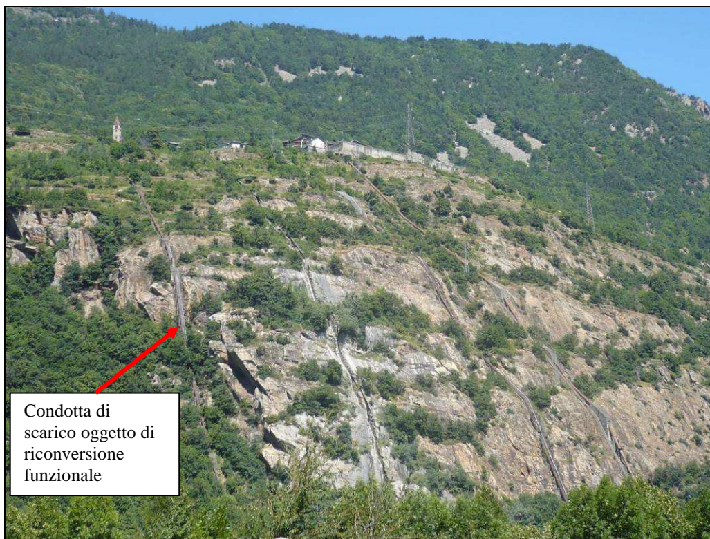
Figura 32 - Panoramica delle condotte poste su versante
