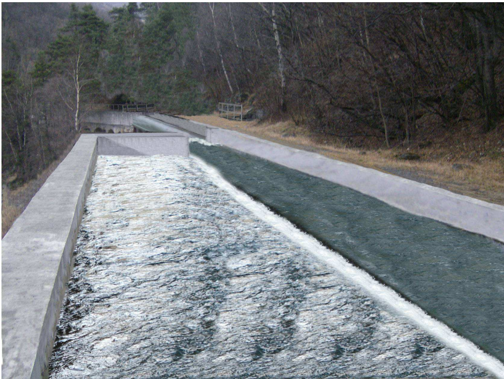
Figura 51 – nuovo dissabbiatore e nuovo canale di gronda con posa nuova tubazione autoportante
