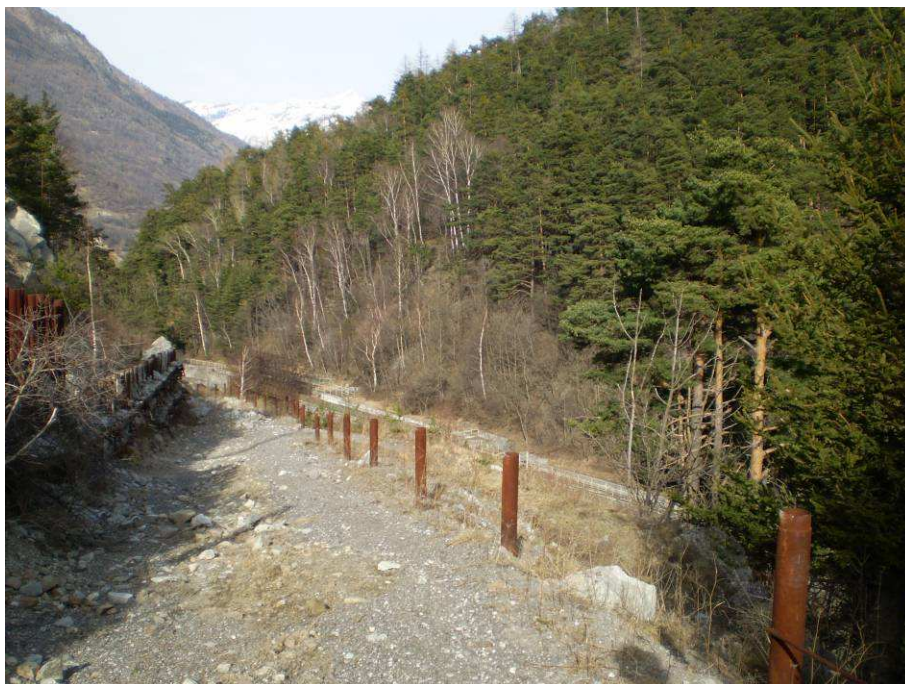
Foto 1 - Accesso alla strada esistente, priva di vegetazione
