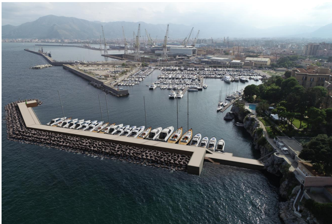
Figura 89: Diga di sopraflutto, lato foraneo – Fotoinserimento
