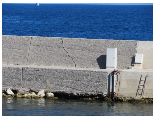
Figura 9.8 - Foto stato di fatto diga di sopraflutto
