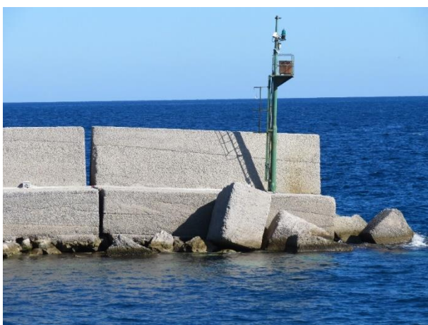
Figura 9.10 - Foto stato di fatto diga di sopraflutto
