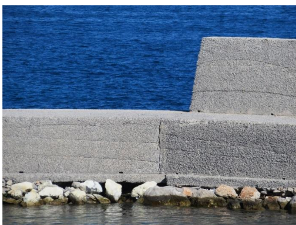
Figura 9.7 - Foto stato di fatto diga di sopraflutto
