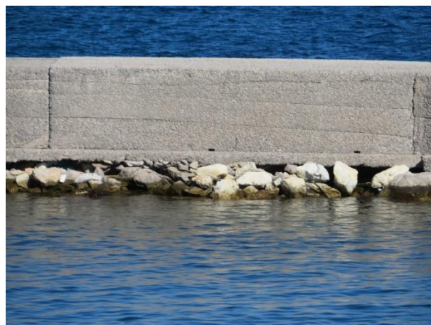
Figura 9.6 - Foto stato di fatto diga di sopraflutto
