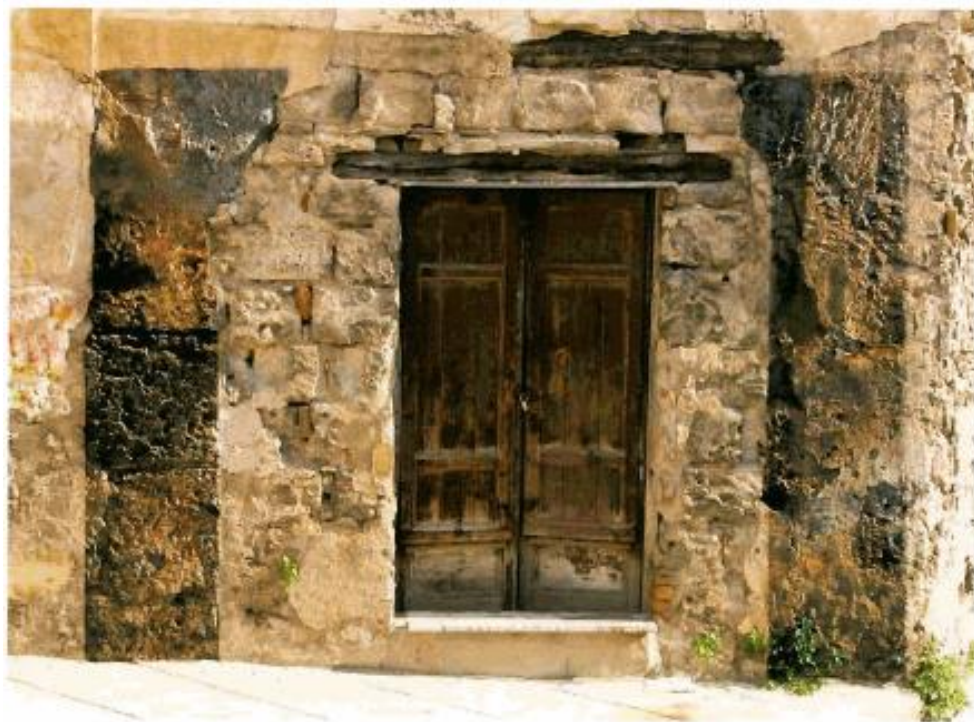
Figura 82: Paramento murario di Villa Lanterna
