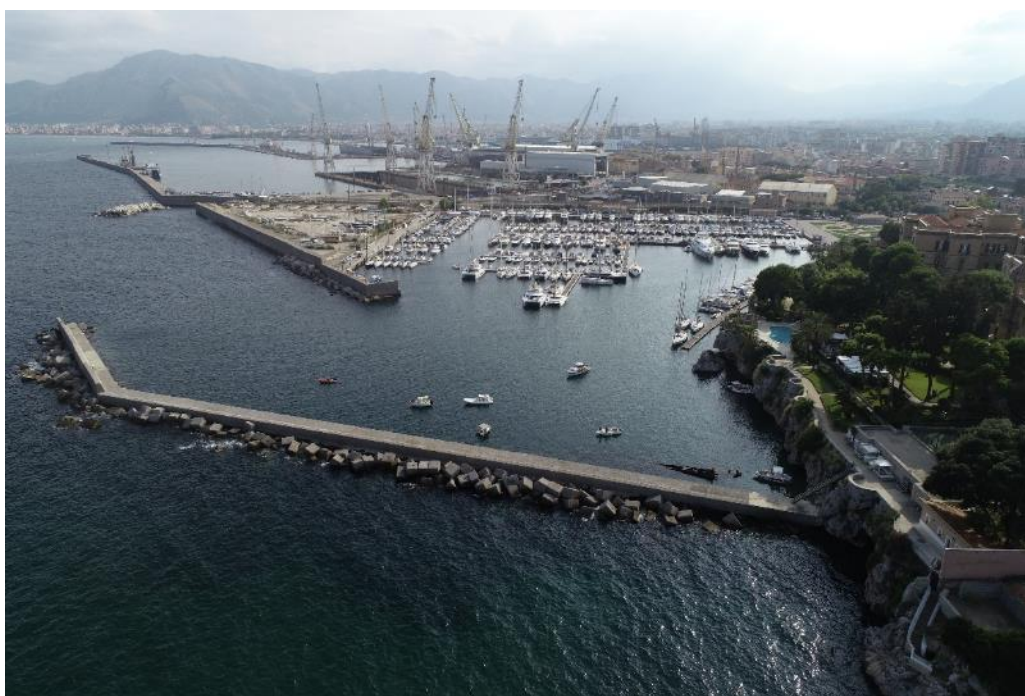
Figura 68: Foto aerea con vista dell'area dell'intervento
