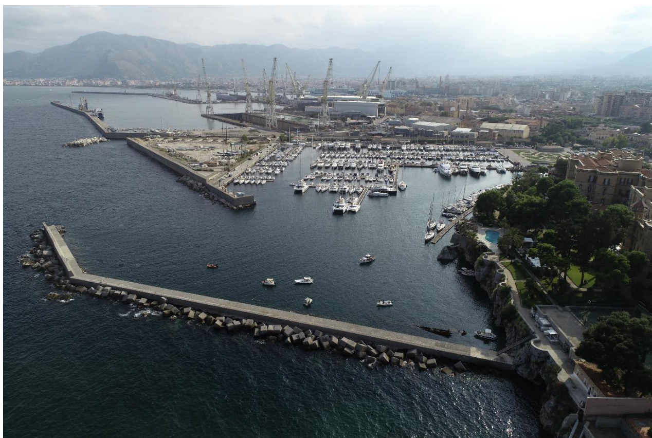
Figura 5 - Molo di sopraflutto del Porto dell'Acquasanta
