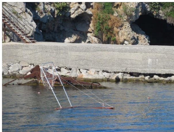
Figura 9.2 - Foto stato di fatto diga di sopraflutto
