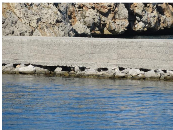
Figura 9.3 - Foto stato di fatto diga di sopraflutto
