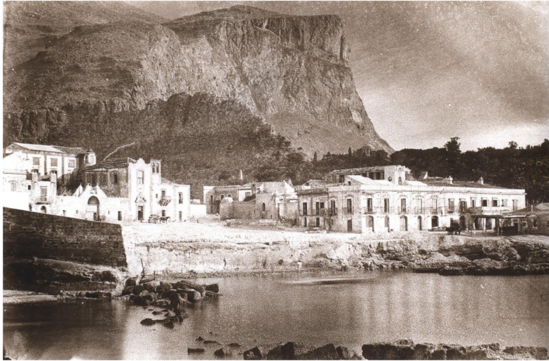
Figura 6 - Veduta storica dell'Acquisanta - Palermo - G. Purpura 1999
