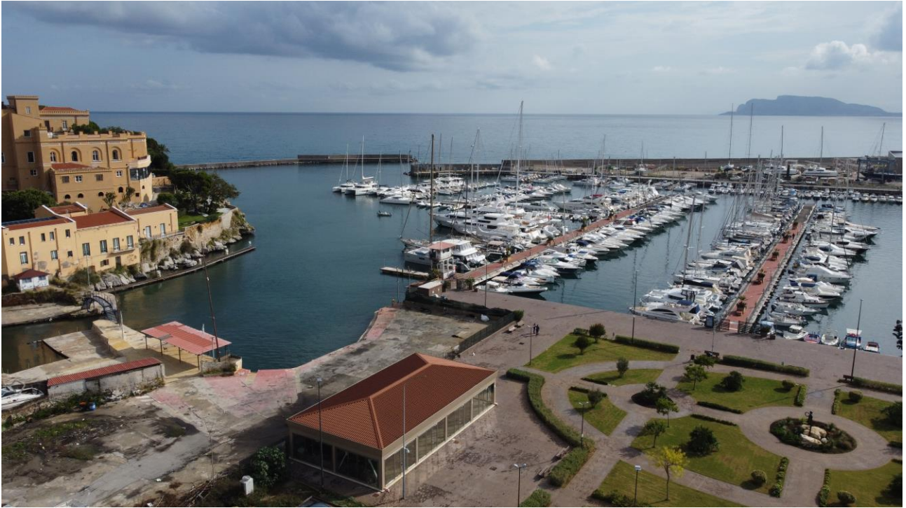
Figura 57: Vista aerea del porticciolo dell'Acquasanta - Stato di fatto
