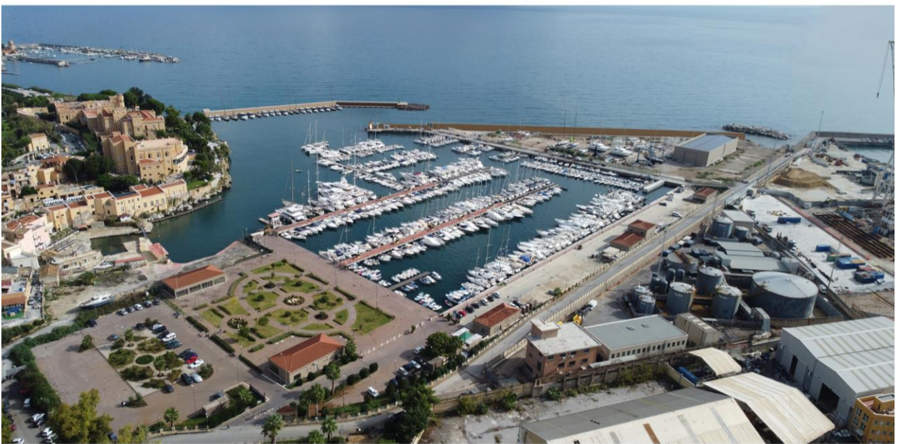
Figura 56: Vista aerea del porticciolo dell'Acquasanta - Fotoinserimento
