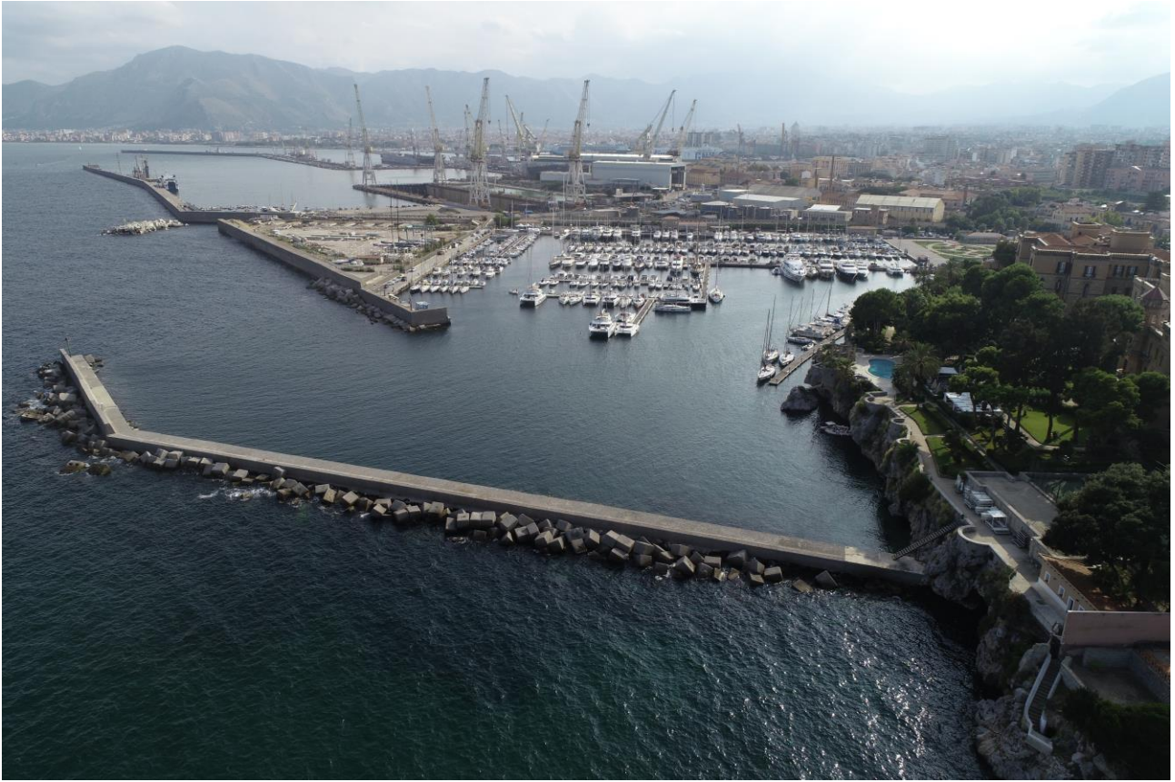
Figura 59: Diga di sopraflutto, lato foraneo - Stato di fatto
