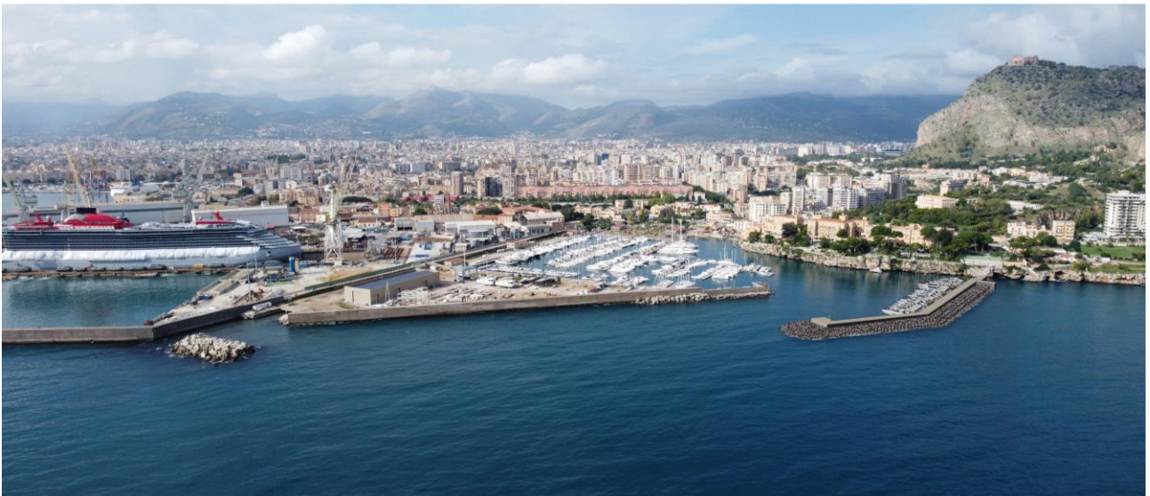
Figura 54: Vista aerea del porticciolo dell'Acquasanta - Fotoinserimento
