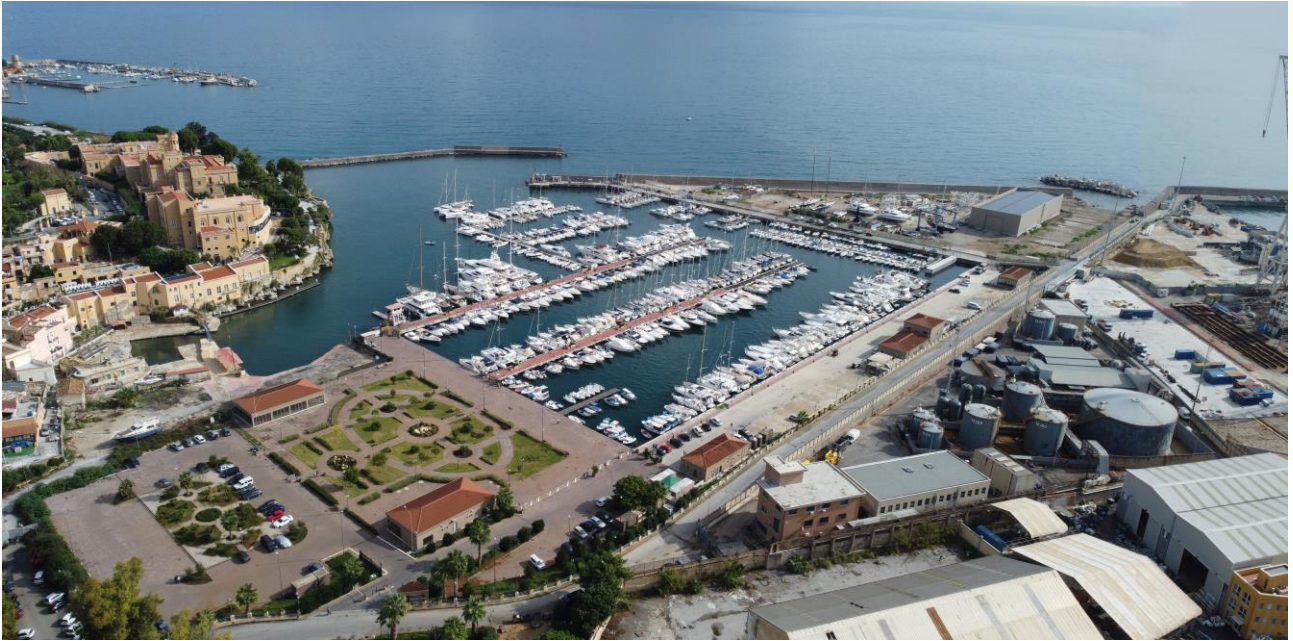
Figura 55: Vista aerea del porticciolo dell'Acquasanta - Stato di fatto
