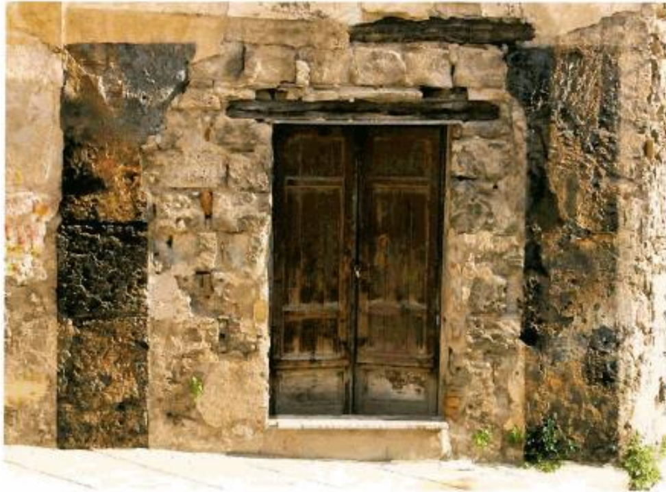
Figura 12: Paramento murario di Villa Lanterna
