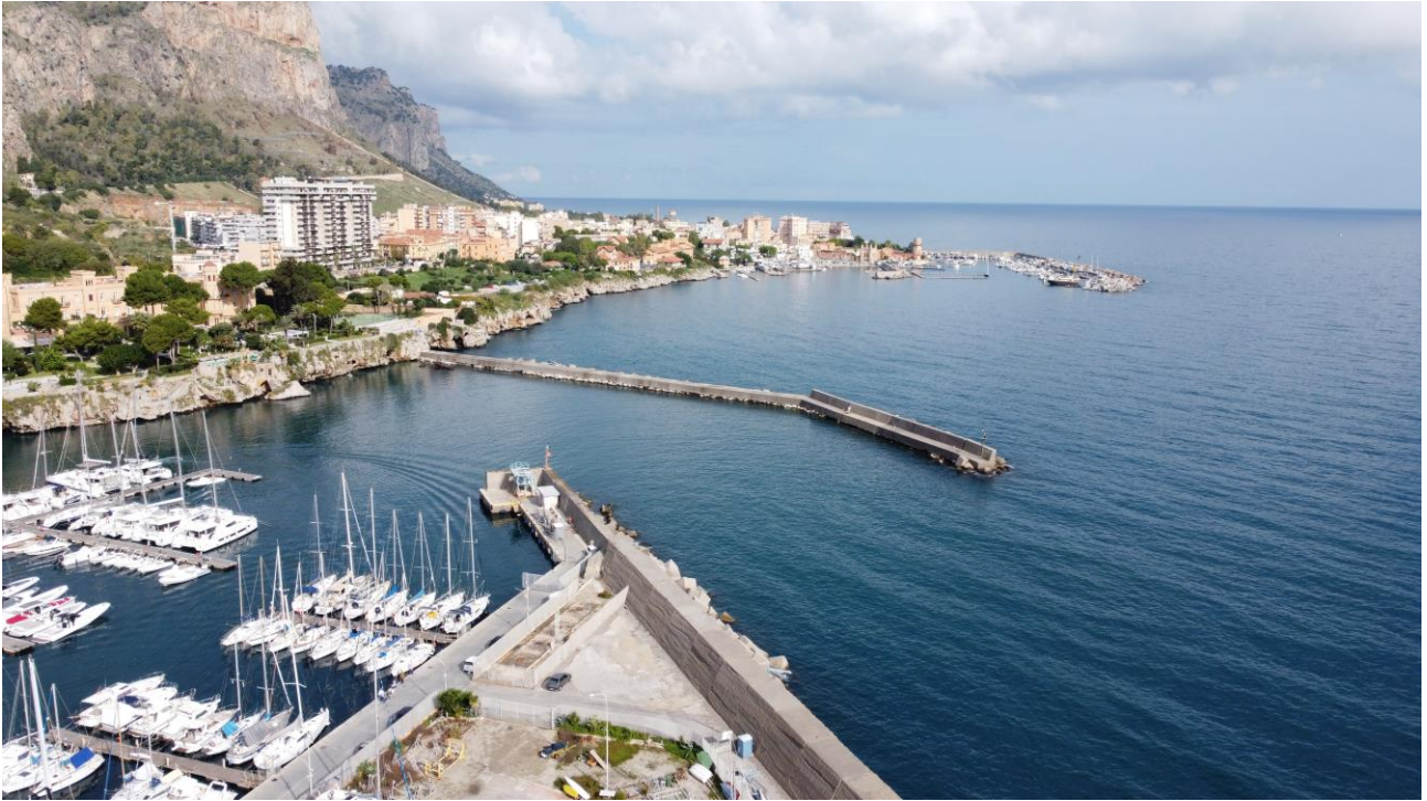
Figura 65: Diga di sopraflutto, lato interno - Stato di fatto
