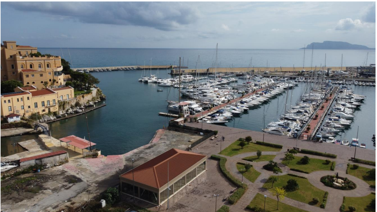
Figura 58: Vista aerea del porticciolo dell'Acquasanta - Fotoinserimento
