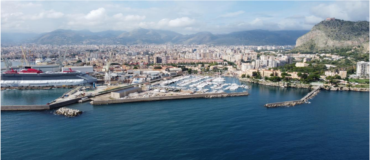
Figura 53: Vista aerea del porticciolo dell'Acquasanta – Stato di fatto
