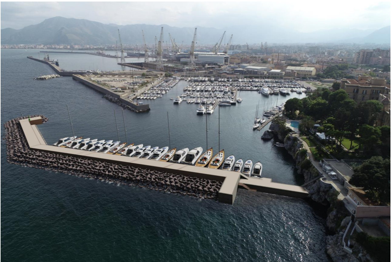
Figura 60: Diga di sopraflutto, lato foraneo - Fotoinserimento
