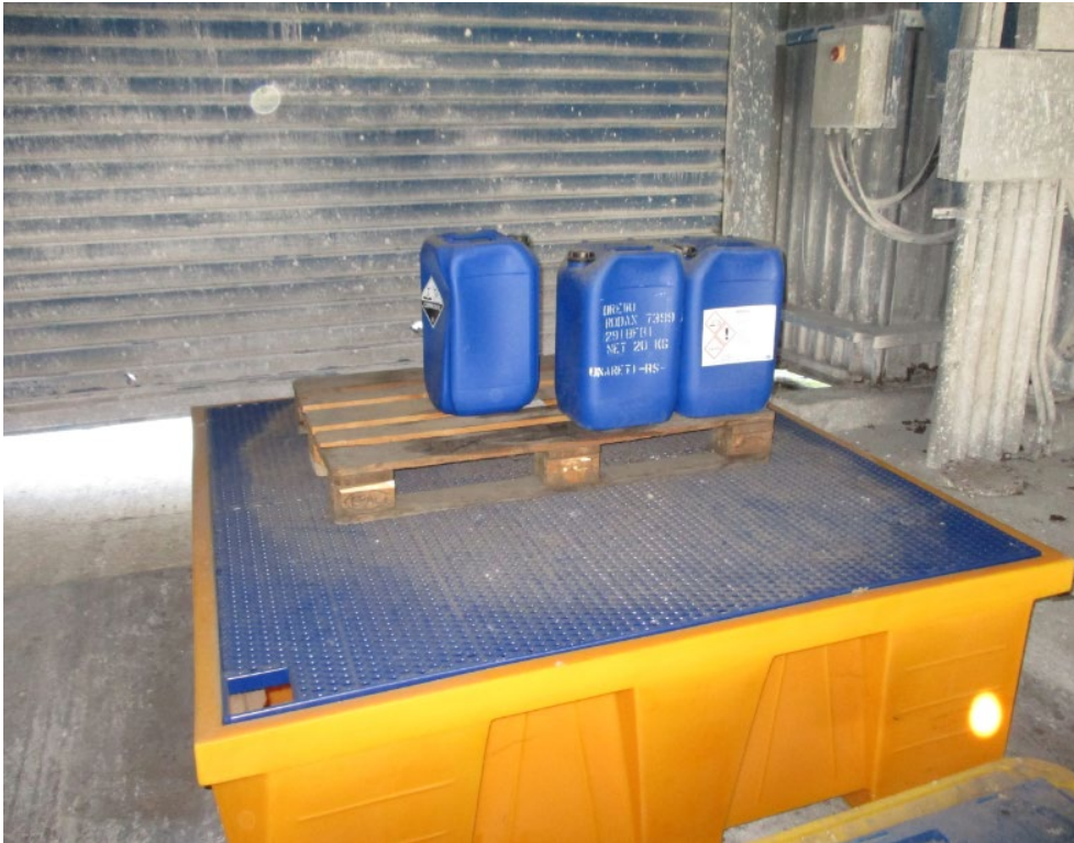
Figura 6.2: Deossigenante (Rodax 7399) - Contenuto in Taniche su Bacini di Contenimento
