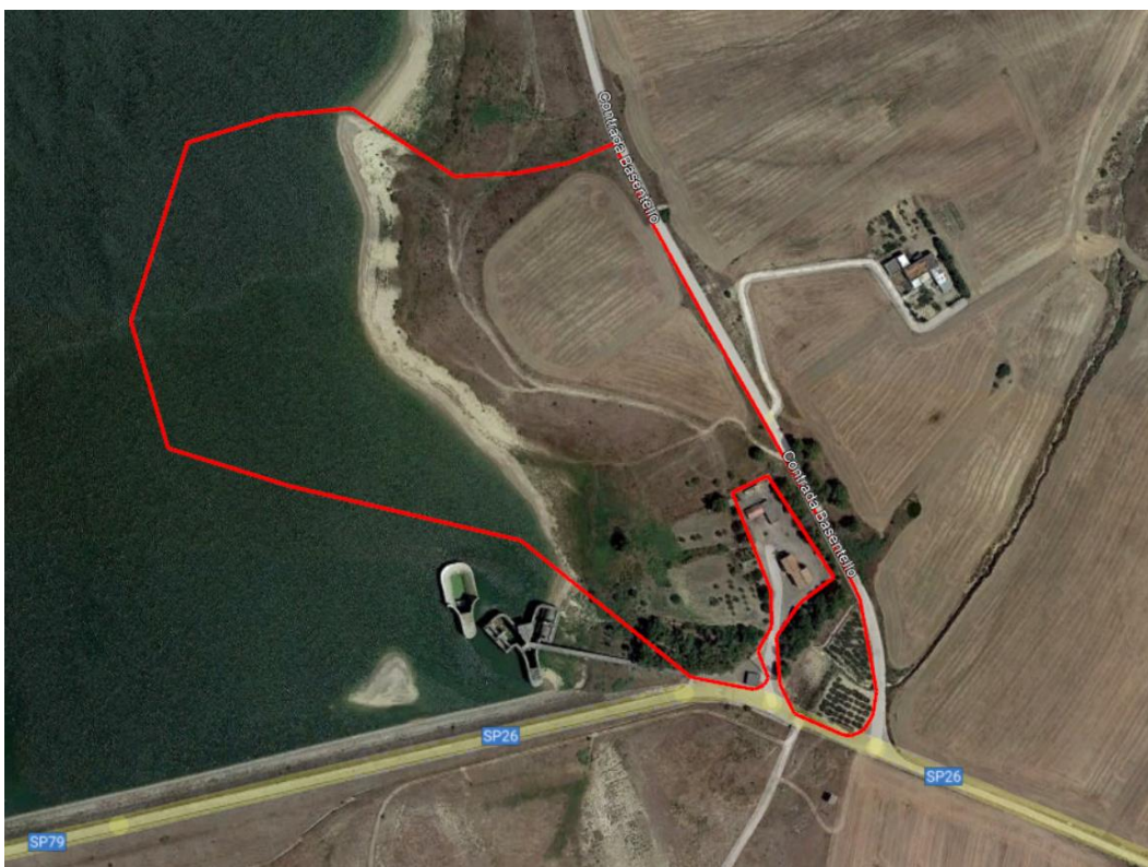
Figura 3 - Cantiere “Bacino di valle”
