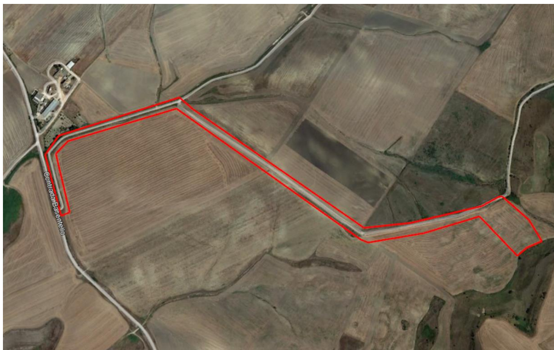
Figura 8 - Cantiere “Finestra intermedia”
