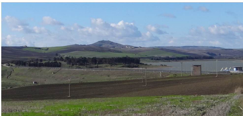
Figura 4.3: Diga di Serra del Corvo da Valle
