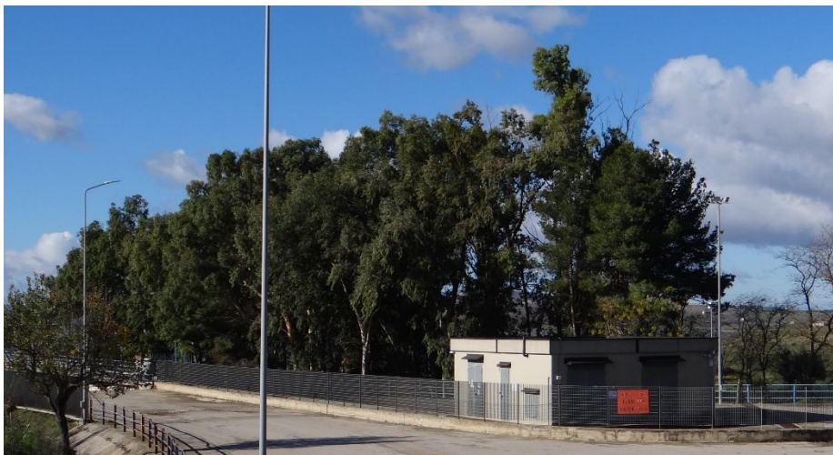
Figura 5.31: Area Centrale e Sottostazione Elettrica
