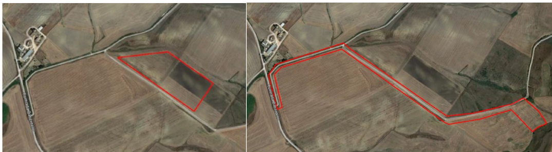
Figura 4.2: Suddivisione Cantiere Finestra Intermedia: Area Servizi (a Sinistra) e Cantiere Principale (a Destra)
