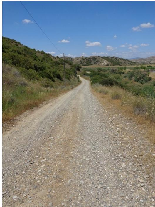
Figura 7: Dopo la posa del cavidotto interrato sarà ripristinata la viabilità esistente con inerte avente la stessa granulometria e colorazione del tratto già esistente
