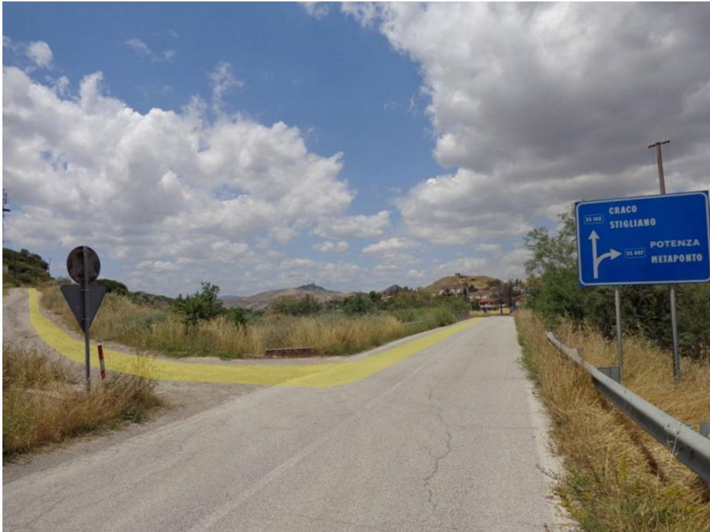
Figura 9: Il cavidotto sarà realizzato su strade già esistenti, dal punto di immissione sulla viabilità sulla SS103 e fino alla stazione di trasformazione
