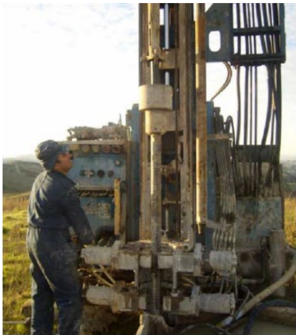
Sondaggio 1 - Prova SPT
