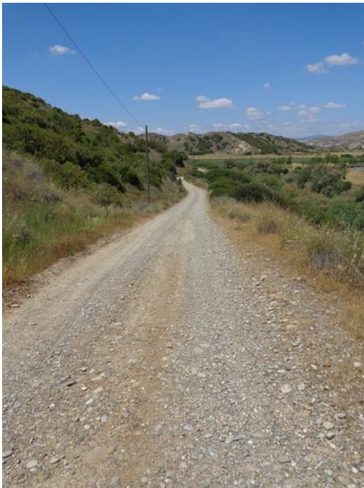
Fig. 14 Strada interpodereale di collegamento con il parco eolico
