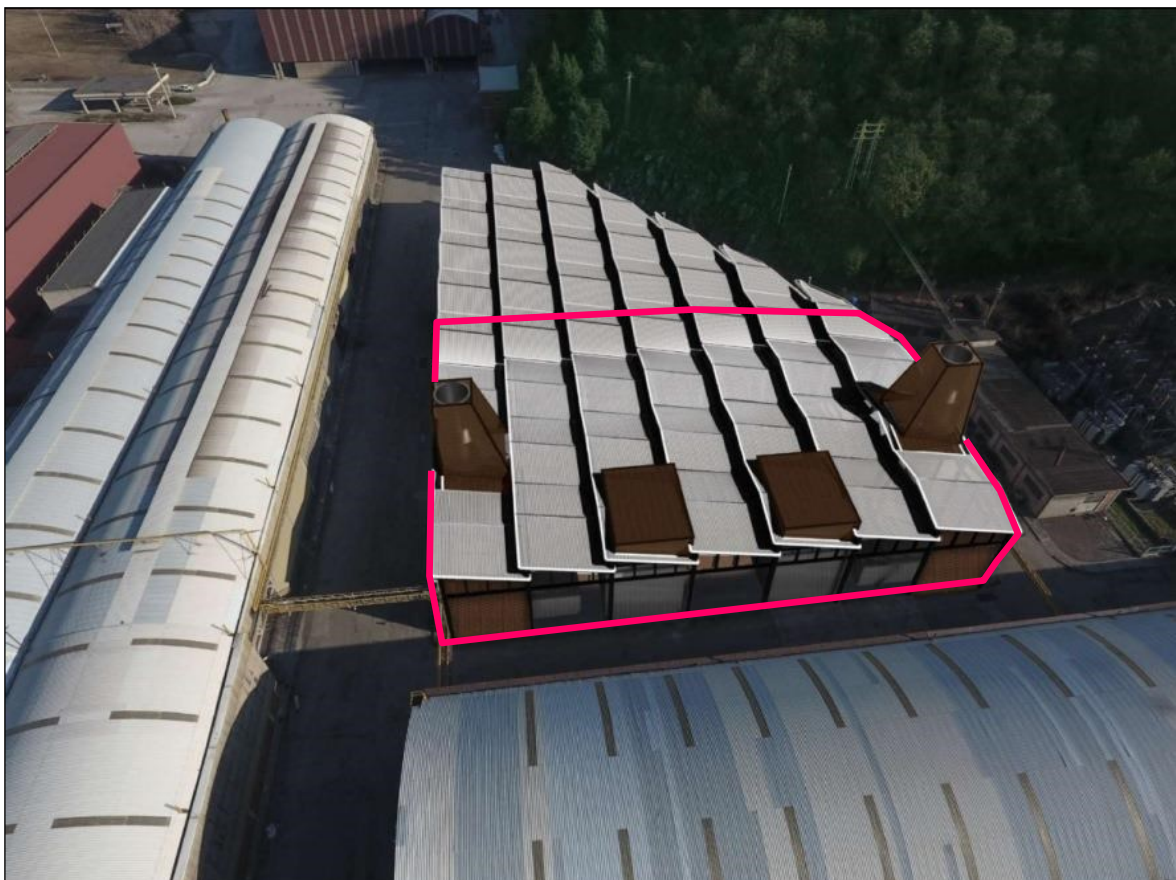
La centrale sarà avvolta da un telaio in acciaio
