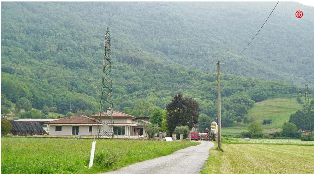
Fig. 8. Elettrodotto 123 su area agricolo-boschiva
