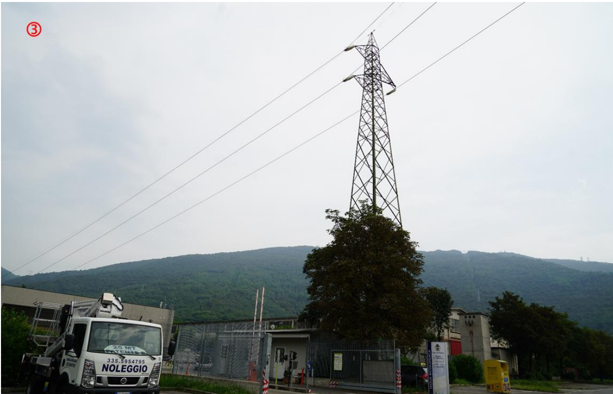
Fig. 5. Elettrodotto 123 su area industriale
