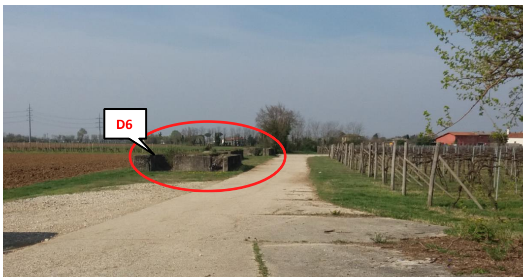
Figura 15 - Manufatti esistenti interferenti con l'asse stradale SL03
