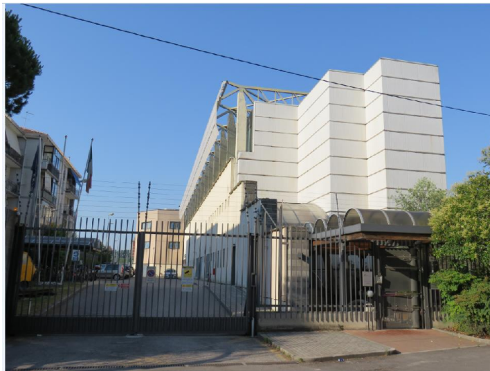
Figura 18: Palazzo SCC di Venezia Mestre
