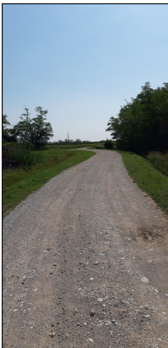
Via Santissima Trinità – viabilità di accesso all'AT.04
