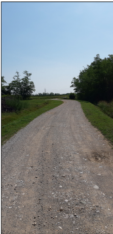
Via Santissima Trinità – viabilità di accesso all'AT.04
